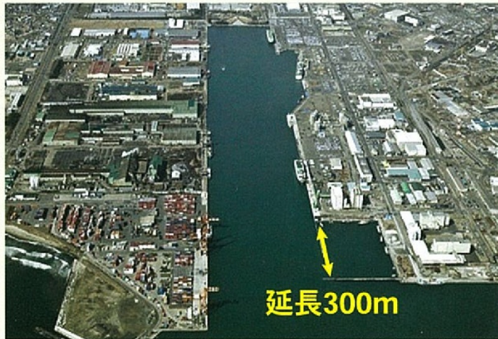
仙台塩釜港全景
