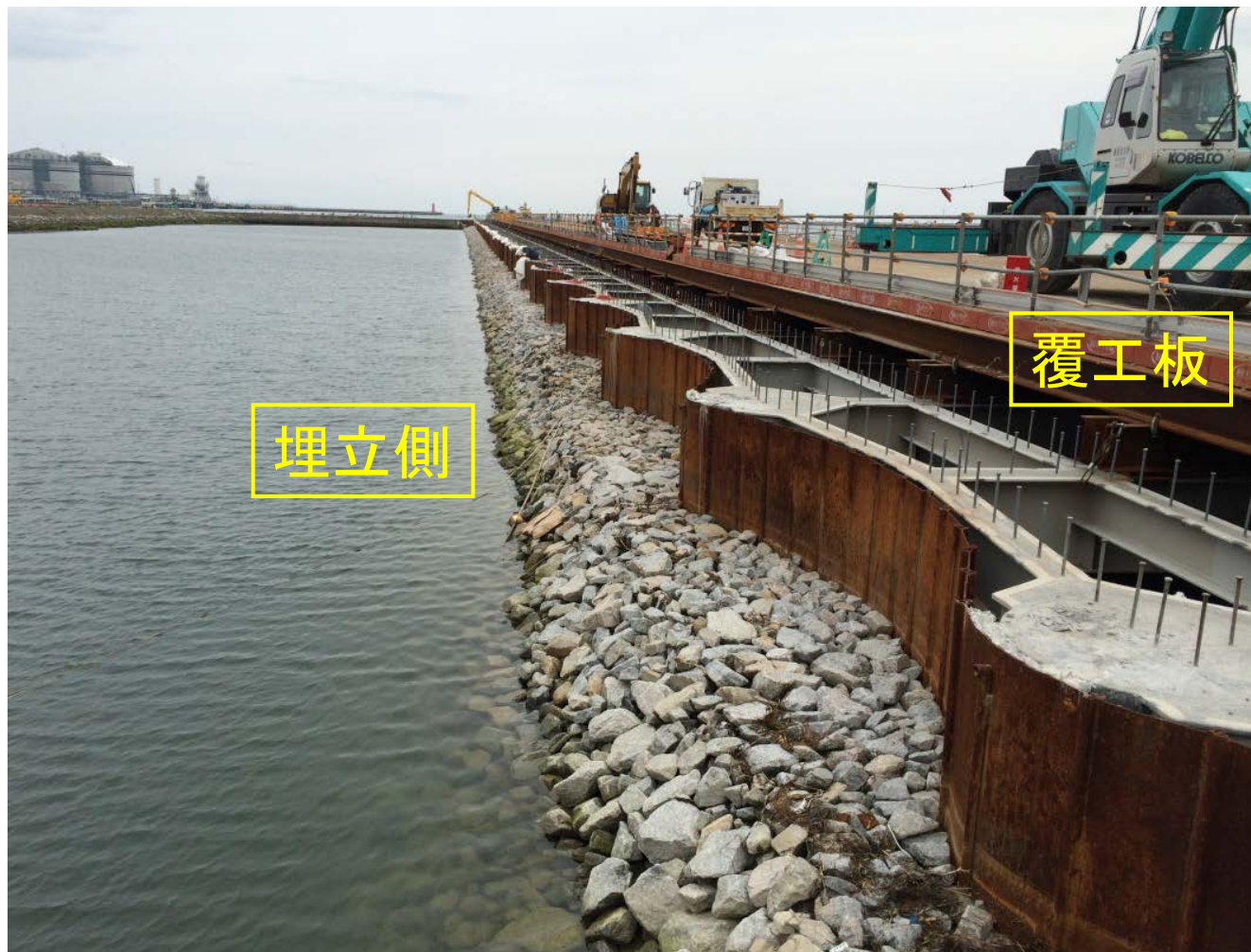
裏込め工完了後の状況
