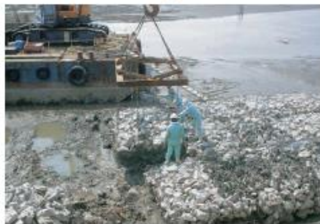
③ 据付け（吊り施工）
