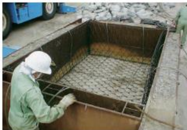
① 組立・型枠設置
