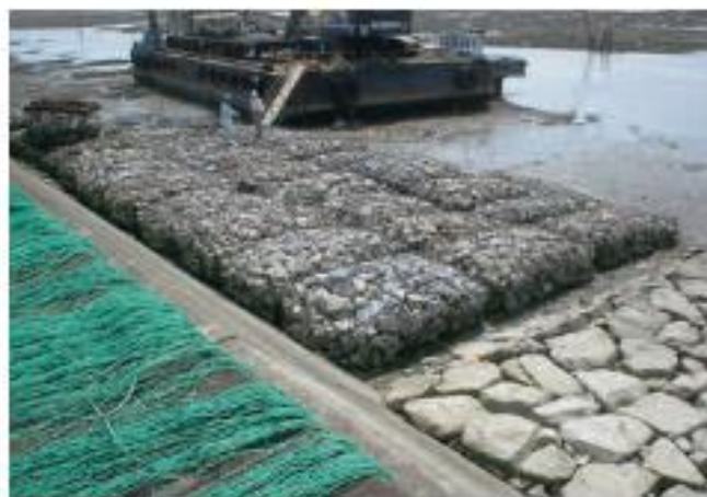
④ 敷設完了
