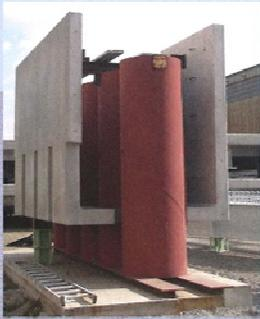
▲ 浮き底型枠取り付け状況
