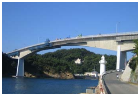
山口県 上関大橋 4,000㎡
