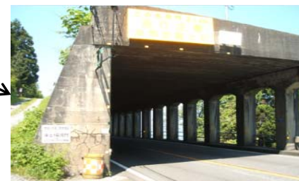
新潟県 国道8号向山同門 3,000㎡
