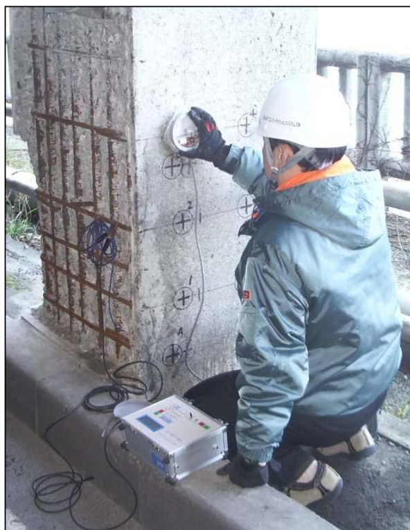
腐食速度測定状況
