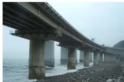
新潟県 国道8号歌高架橋 8,000㎡
