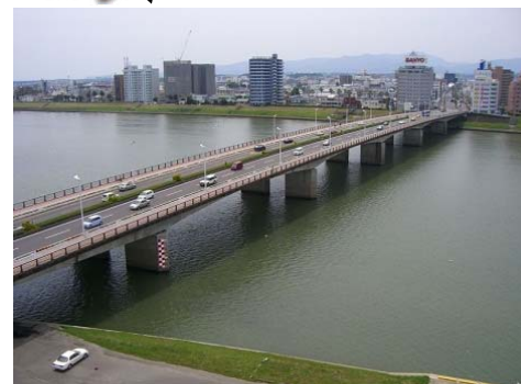
宮崎県 国道220号橘橋 10,000㎡
