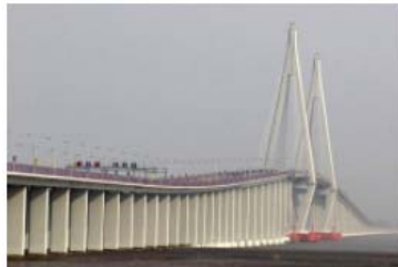
中国 杭州市 杭州湾大橋（コンクリートピア） 36km
