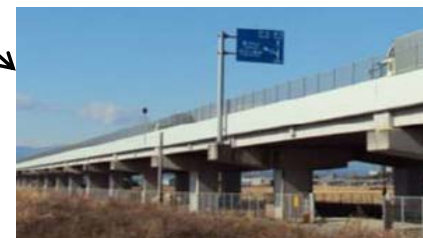
静岡県 国道1号沼川高架橋 3,200㎡
