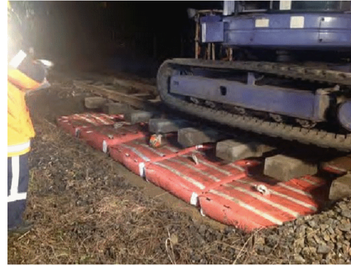
JR西日本：草津線 地盤補強と噴泥対策工事（LS100－1段）
