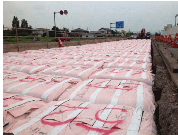
埼玉県加須市内 国道125号・地盤補強工事（一部沼地に道路を建設）
