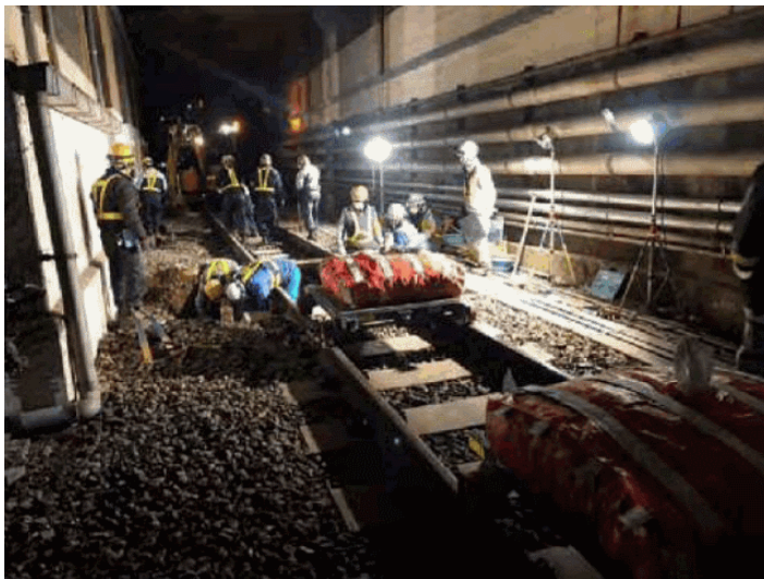
JR東日本：都内 地盤補強と噴泥対策工事（LS100－1段）
