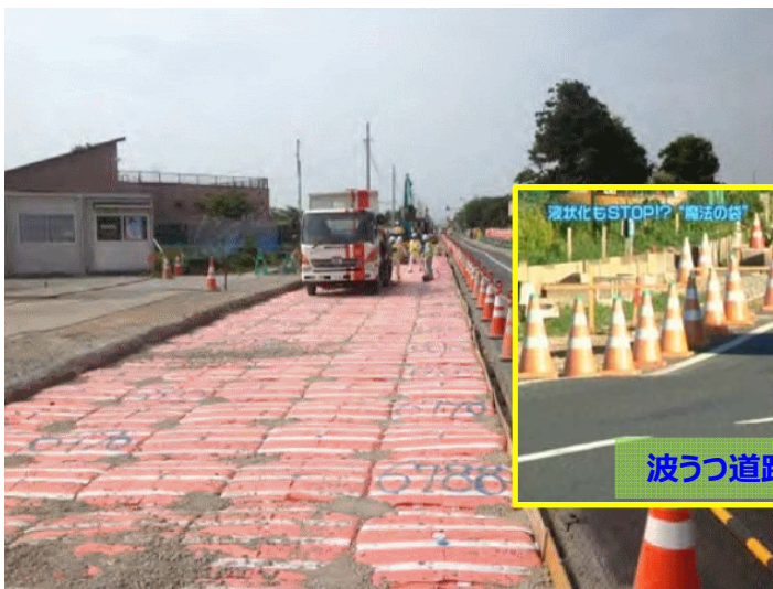
茨城県神栖市道・液状化対策工事（東日本大震災） （24国災第1730号市道6-9号線道路災害復旧工事）
