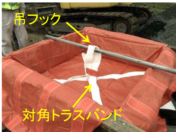
専用型枠内にD・Boxをセット
