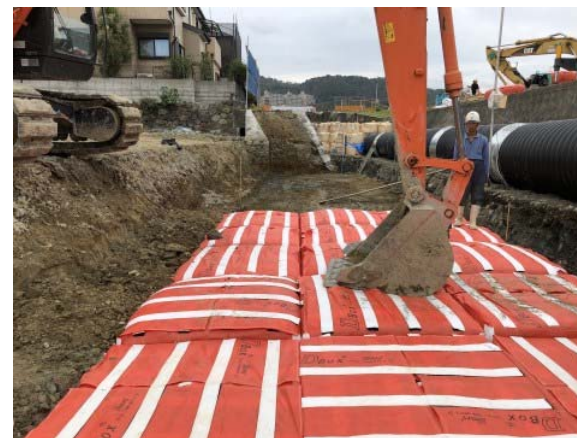
バックホウ・加圧貫入
