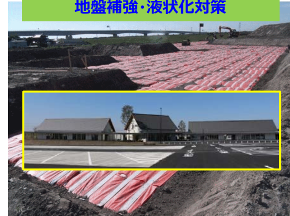
滋賀県長浜市：L型擁壁地盤補強
