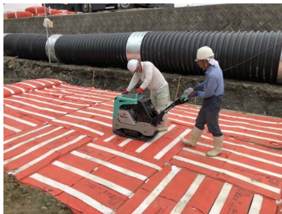
振動コンパクター・加圧貫入
