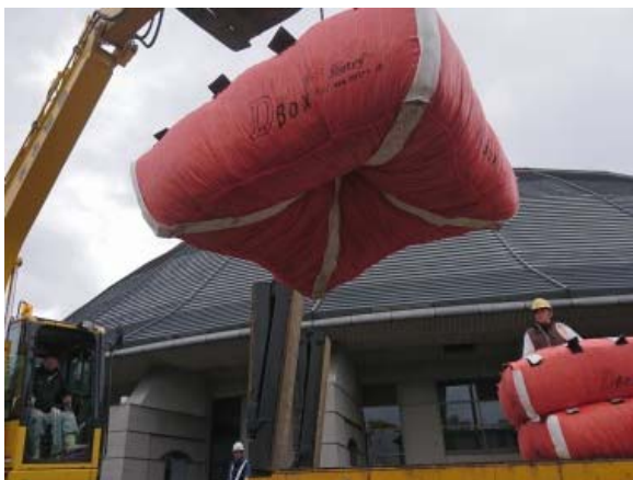
D・Box吊上げ
