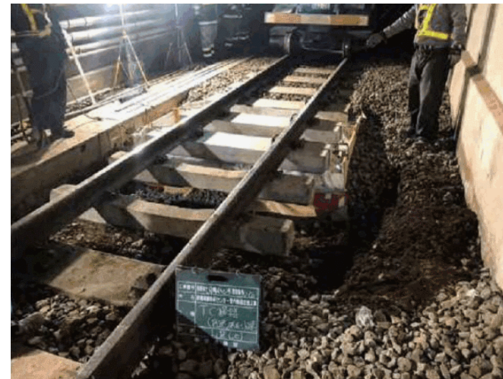
JR東日本：都内 地盤補強と噴泥対策工事（LS100－1段）
