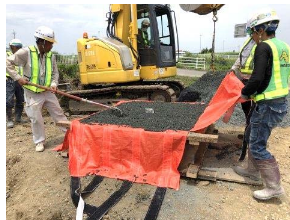
型枠天端まで投入
