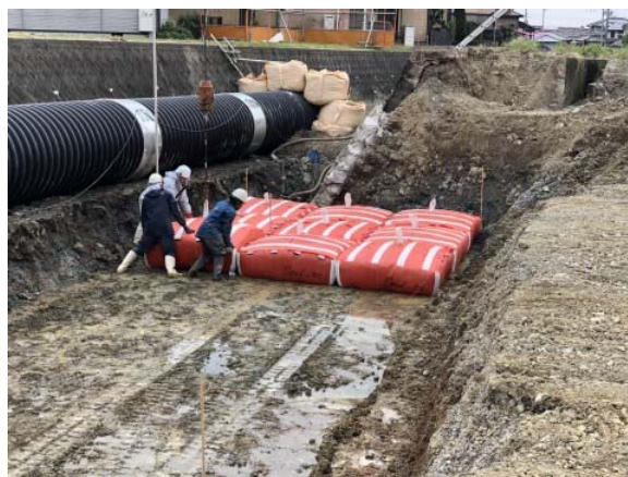
D・Box敷設
