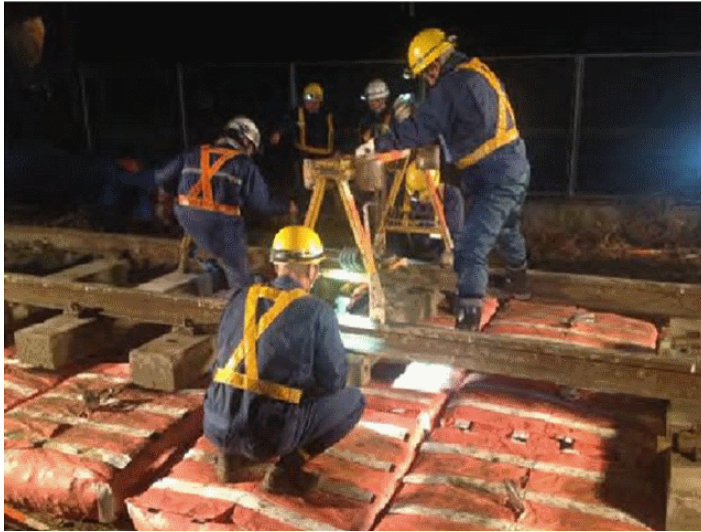
JR西日本：草津線 地盤補強と噴泥対策工事（LS100－1段）
