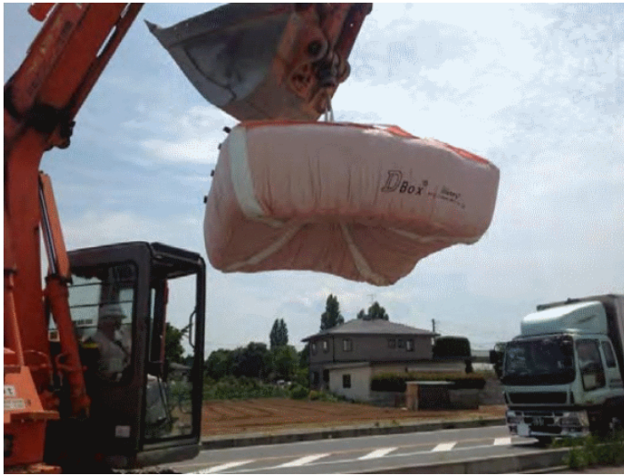
埼玉県加須市内 国道125号・地盤補強工事（一部沼地に道路を建設）
