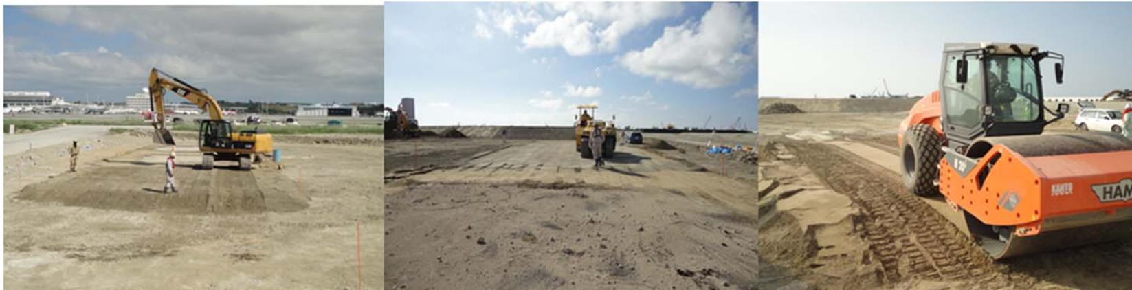
バックホウ敷き均し 13Tタイヤローラー 20T振動ローラー
