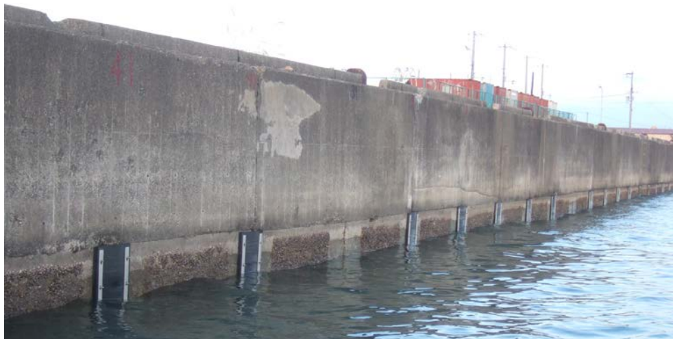
■RF-AS型目地材（両止めタイプ、構造物前面目地用）
