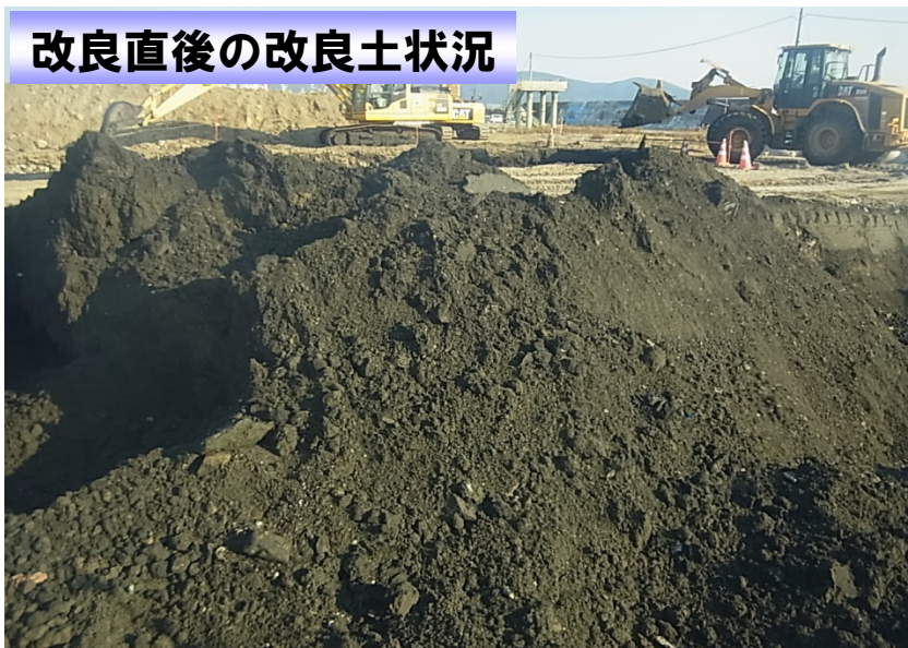
改良土の仮置き（敷均し・締固め）状況
