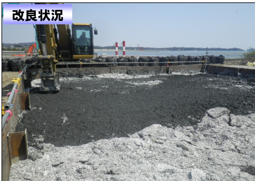
仮置き場での敷均し・締固め状況
