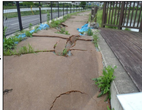
浅層混合処理工法による 施工箇所
