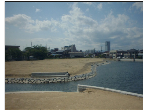
ポンテラン改良土 による 施工箇所
