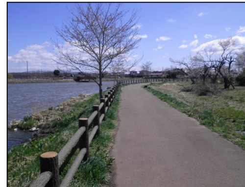
ポンテラン改良土 による 施工箇所
