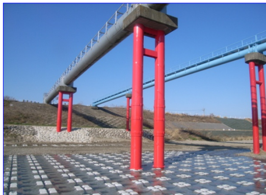
三滝川水管橋下部工耐震補強工事 三重県企業庁:(H19.9～H20.3)
