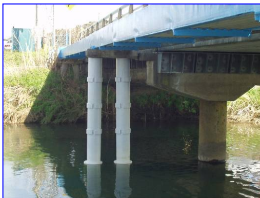
佐倉(耐震補強)通信設備総合工事 NTTインフラネット(株):(H21.11～H22.3)
