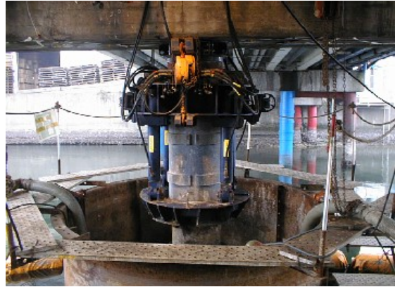
② 圧入装置設置
