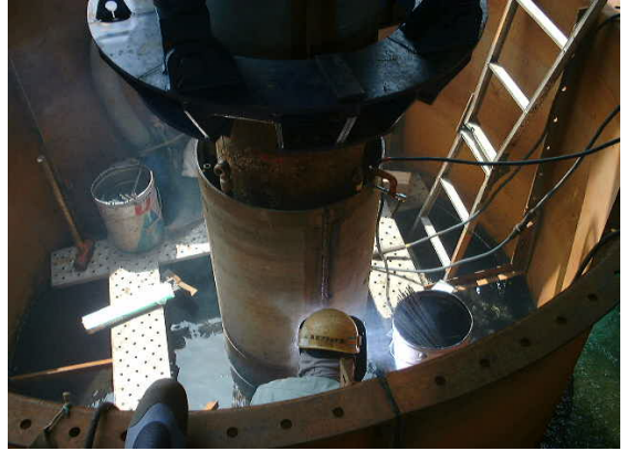
④ 補強鋼板設置、溶接
