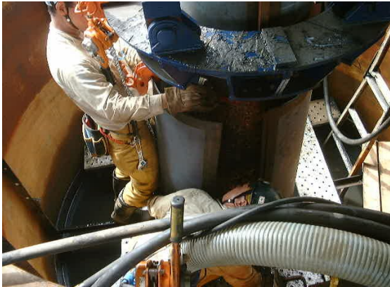
③ 補強鋼板設置
