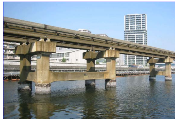
コンクリート支柱基礎杭耐震補強工事 東京モノレール(株):(H20.2～H21.7)
