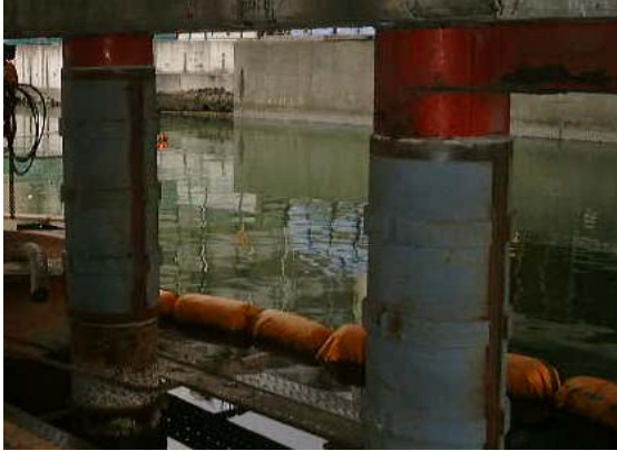
① 反力用鋼板設置
