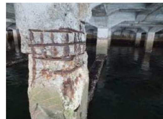
栈橋脚柱部鉄筋露出
