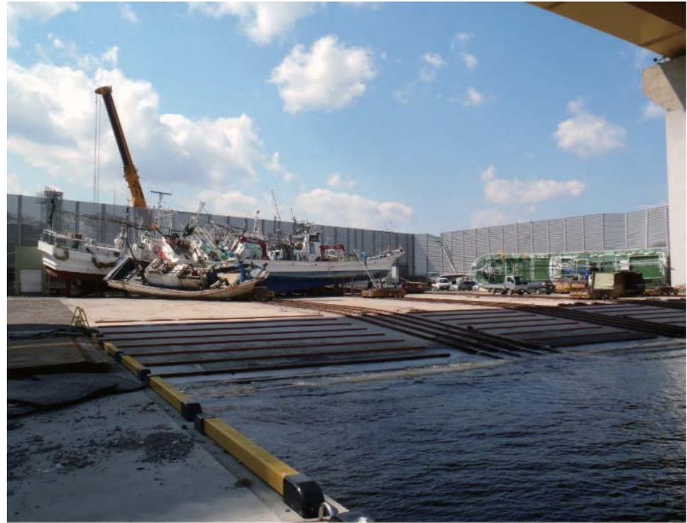
津波漂流物を捕捉し、堤内地の被害軽減に寄与したと見られる事例
