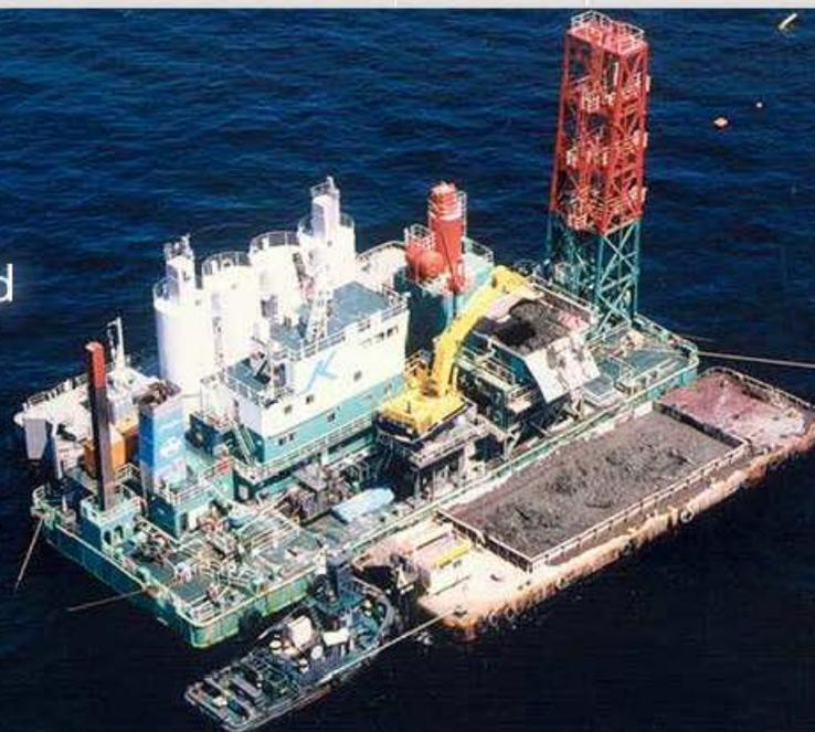
**プレミックス船工法**は、専用のプラント船を用いて軟弱な浚渫土をセメントなどの固化材と攪拌混合して所定の強度と流動性を有する固化処理土を製造し、埋立柱や護岸の裏込材料として使用する工法です。プレミックス船は、浚渫粘性土と固化材を混合・攪拌するミキサー、固化処理土を圧送・打設する大容量ピストンポンプ等を搭載し、固化処理土の製造から打設まで1隻で施工が可能です。
