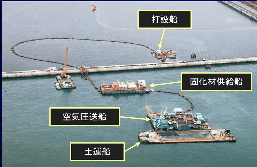
管中混合処理工法の船団構成
