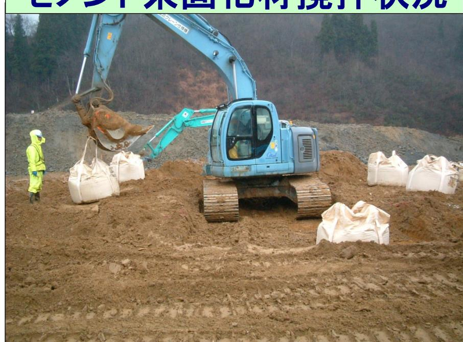
本工法では、攪拌機付きバックホウとボンファイバーおよび固化材等の改良材を現地に搬入するだけで原位置で改良が可能である。広大な敷地や特殊装置が不要となり、大幅なコスト削減が可能となる。
