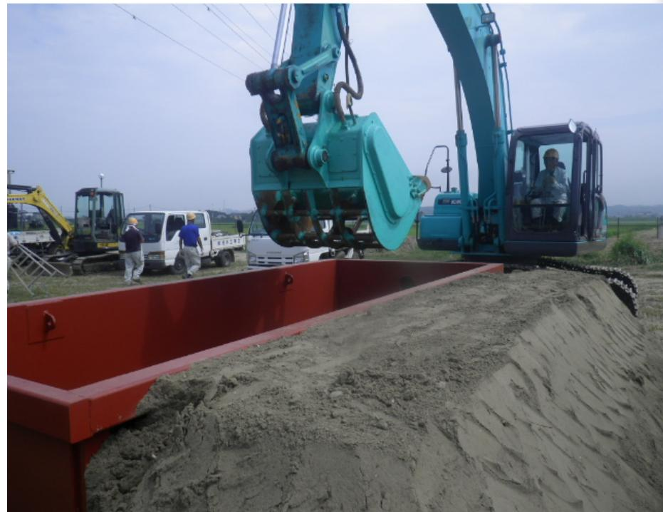
**④ 普通バックホウと攪拌アタッチメントのみで改良が可能のため、大掛かりな仮設設備が不要。**
