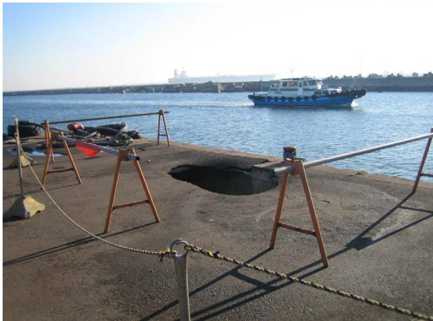
鋼矢板腐食による吸い出し陥没
