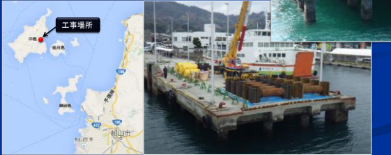
Re-Pier(伸縮式ストラット)工法
