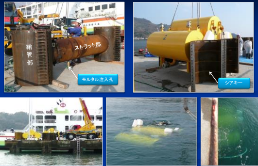
Re-Pier(伸縮式ストラット)工法
