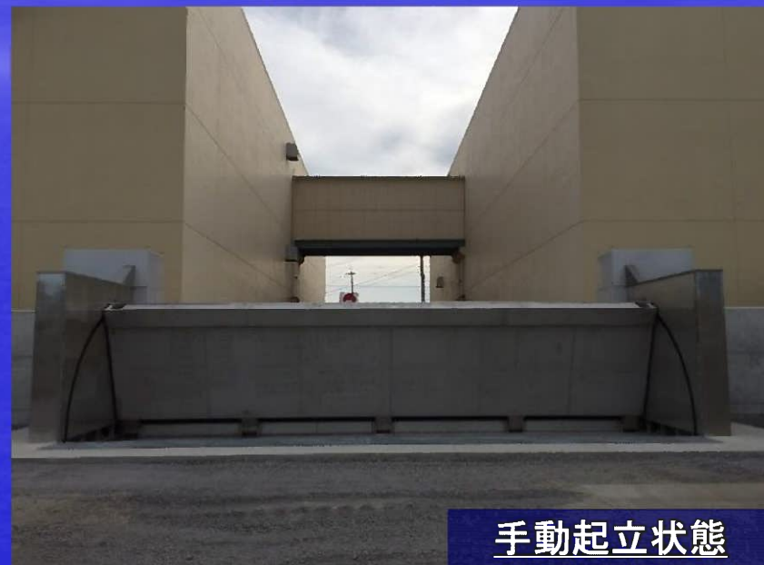
2015.10完成 徳島県撫養港海岸陸閘
