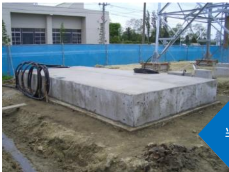
〔保護材、施工前〕
