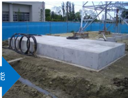
〔保護材、施工後〕
