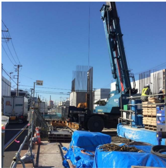
川崎市 東扇島臨港道路アプローチ橋梁下部工事
