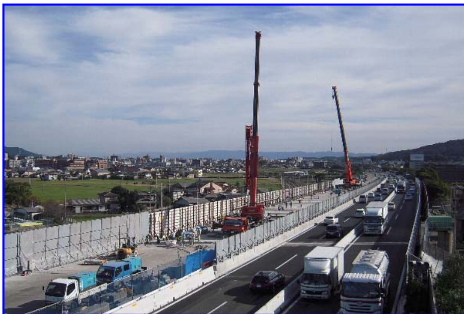
九州自動車道 向佐野橋 大宰府IC～筑紫野IC間 日交通量約10万台
