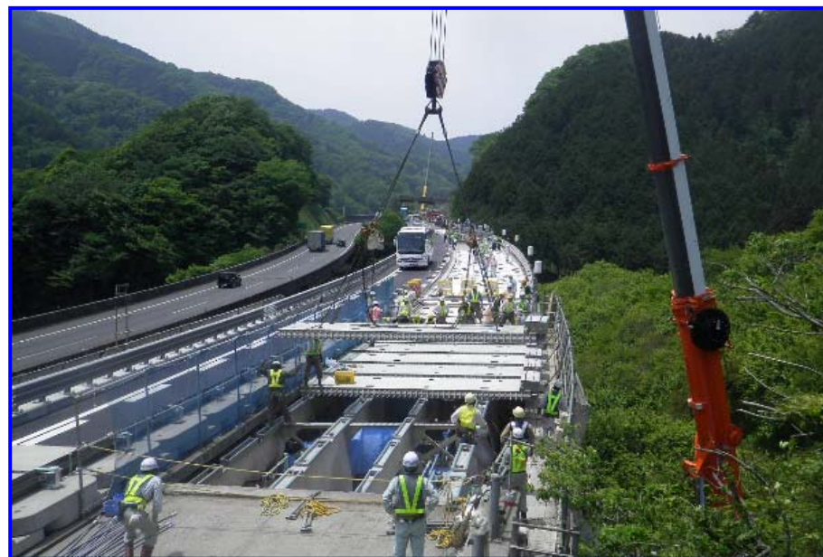
中央自動車 上長房橋 八王子JCT～相模湖東IC 半断面施工
