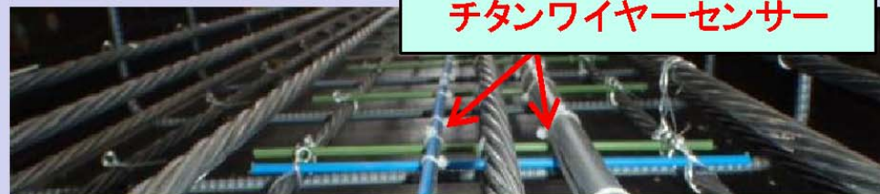
新設PC桁への設置
