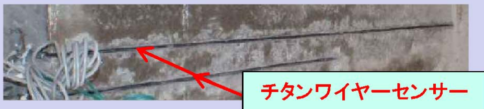
溝切削による設置
