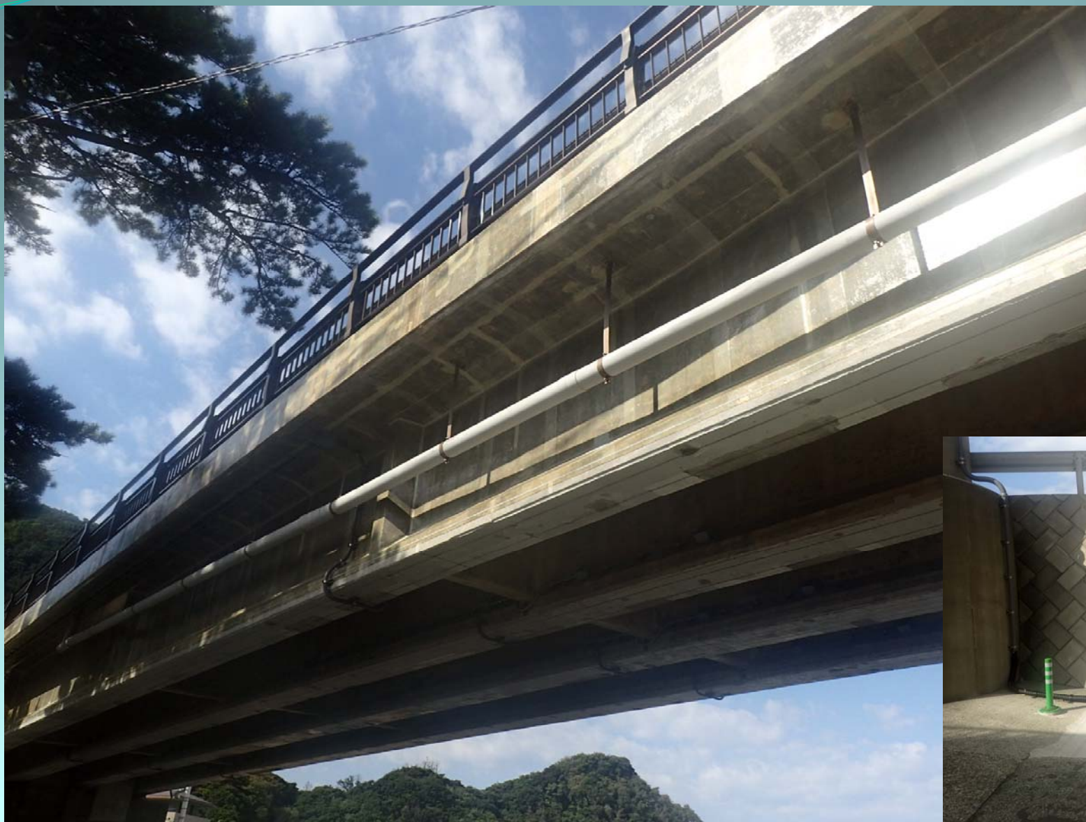
静岡県内の橋梁 PI-Slit工法
