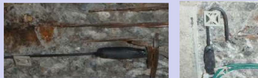
断面修復部への設置
