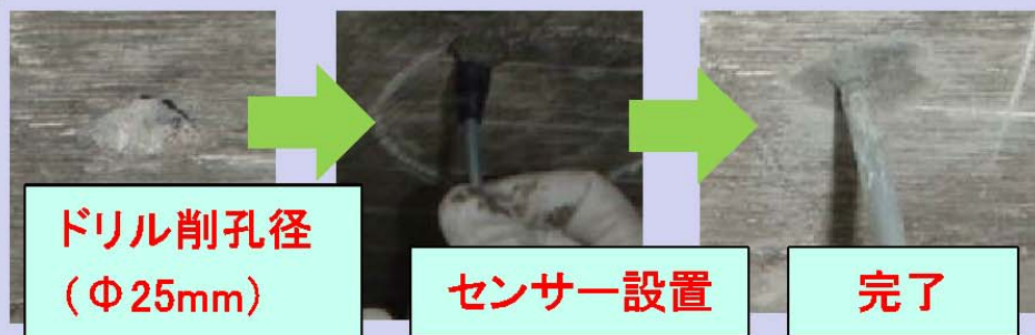
ドリル削孔による設置
