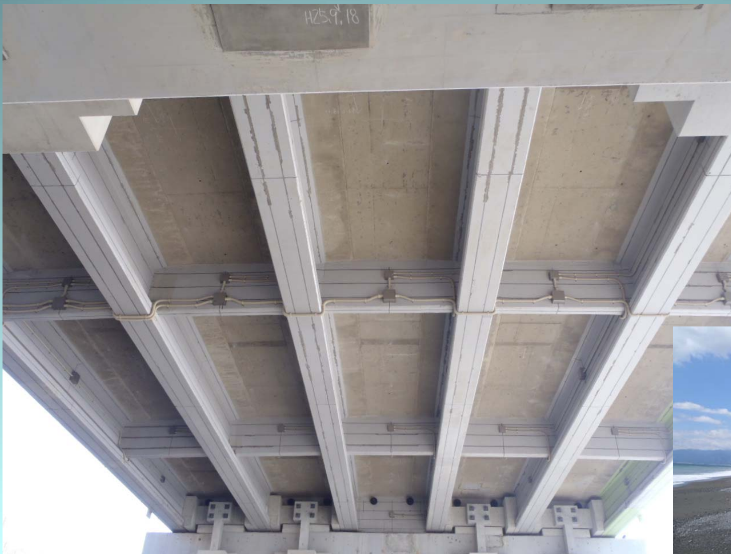
神奈川県内の橋梁 PI-Slit工法
