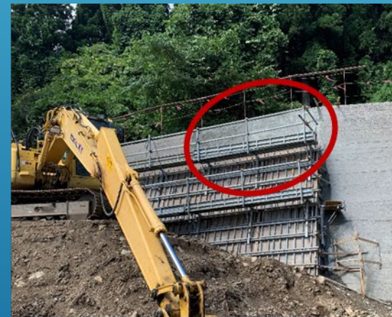
塗布完了（赤丸部）
