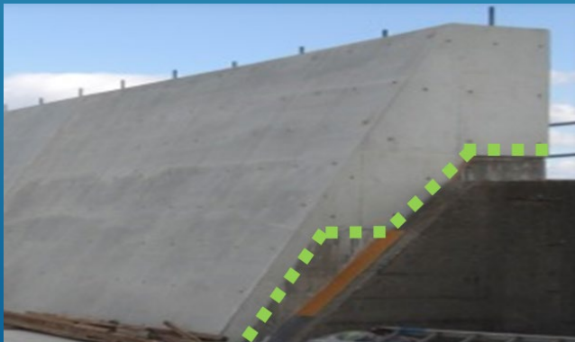
(例) 護岸の嵩上げ
