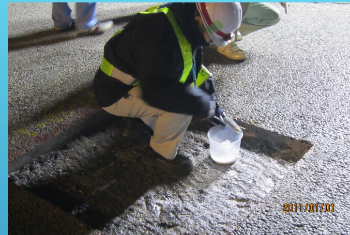
プライマー塗布状況
