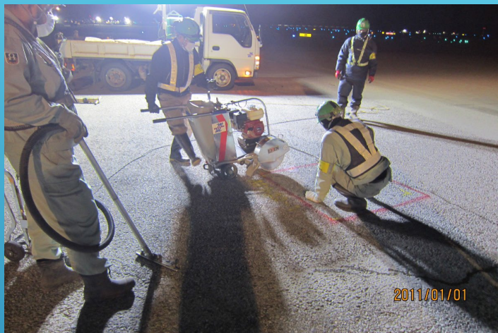
カッター切断状況
