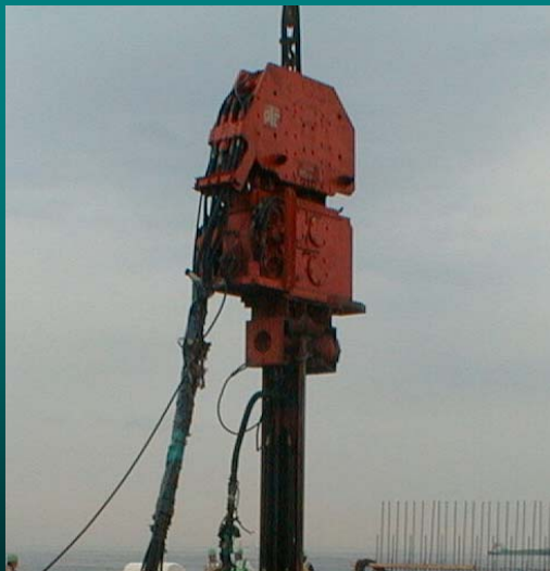
バイブロハンマ打設
