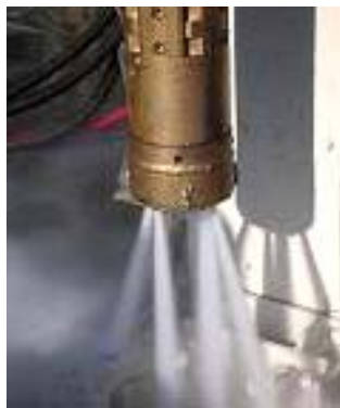
ジェット削孔状況
