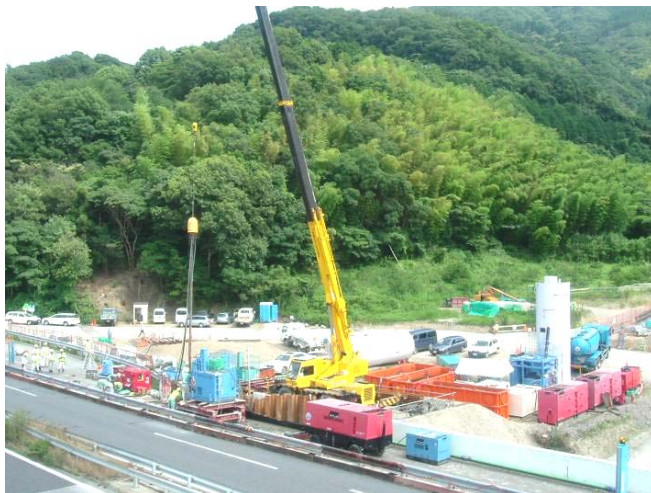
施工状況写真
