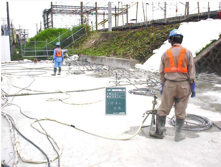
鉄道盛土直下注入状況
