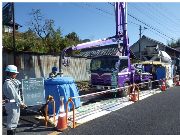
打設状況 (コンクリートポンプ車)
