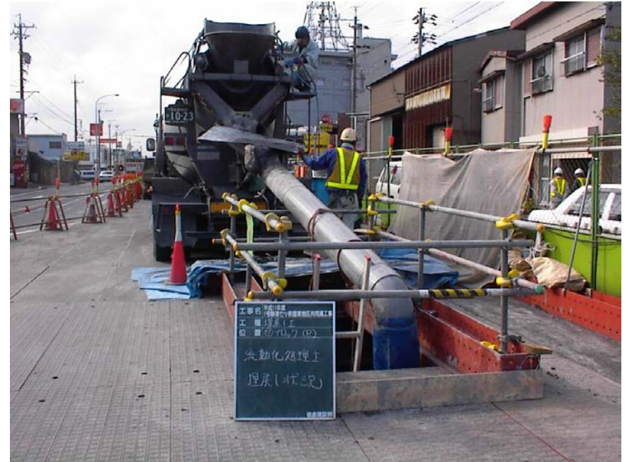
アジテーター車（運搬車）から直接
