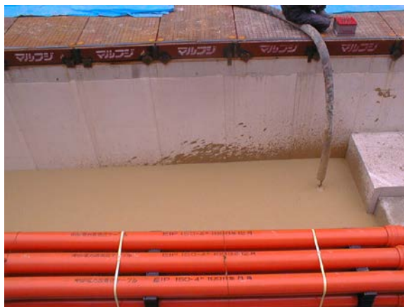
埋戻状況（多条埋設管部）
