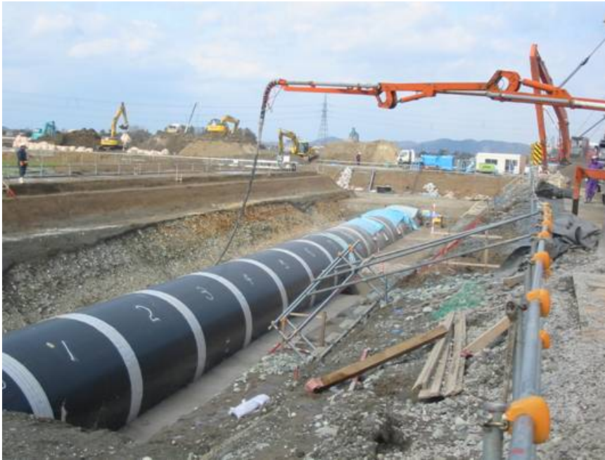
コンクリートポンプ車
