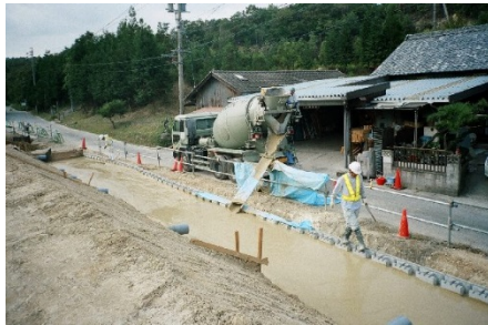
打設状況（シュート）
