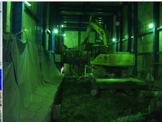
LSS製造状況（解泥作業）
