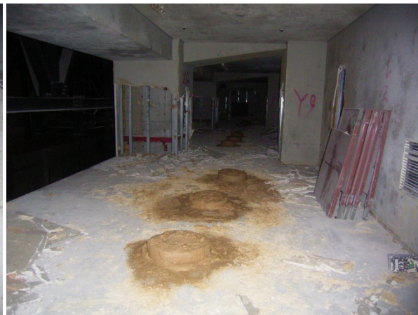
充填完了（地下ピット）
