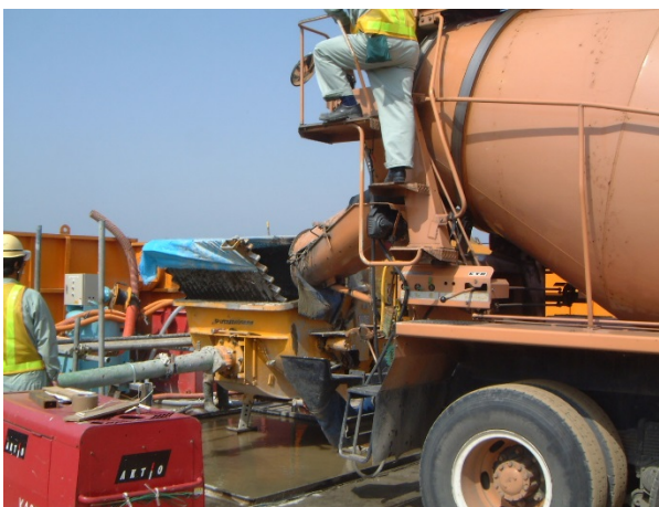
打設状況 (定置式コンクリートポンプ)
