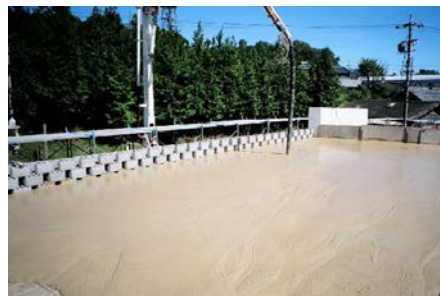
打設状況（コンクリートポンプ車）
