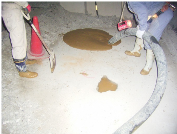
充填状況（地下ピット）
