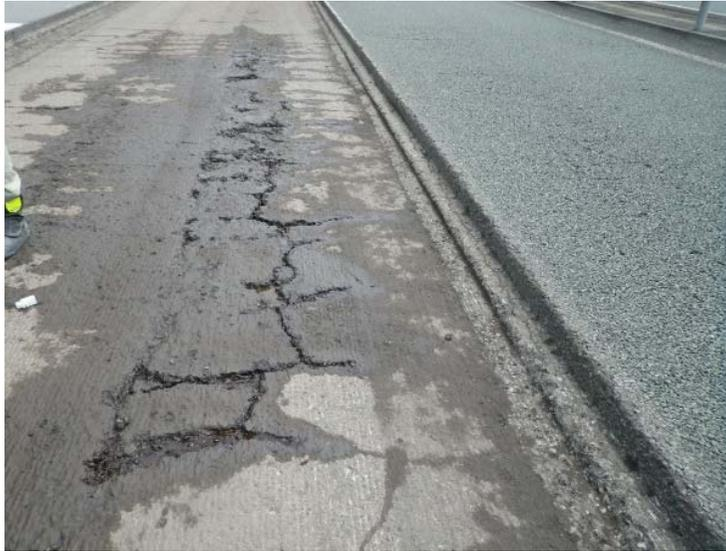
対策：表層・基層アスファルトを切削し、上層路盤面のクラック部分に注入材充填の上、路盤面直上にCG100を敷設。
