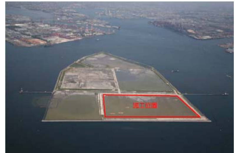
施工位置写真
