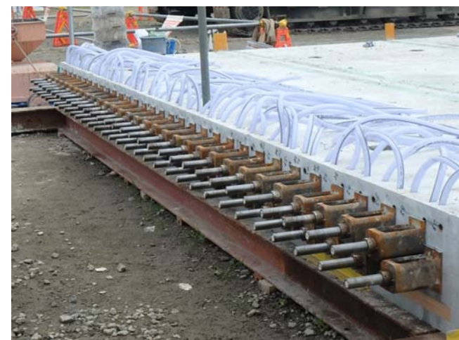
ポストテンション緊張用端末 (グラウト強度発現後切断)
