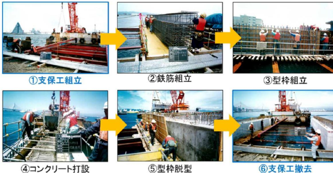
写真-3 海上での受梁施工状況
