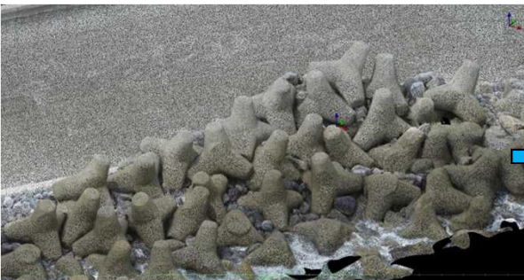
●消波工の点群データ (現地検討)
