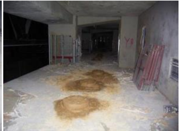
充填完了（地下ピット）
