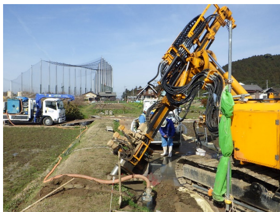
削孔状況（パーカッションドリル） プラント全景（現地設置型プラント） 充填状況（コンクリートポンプ車）
