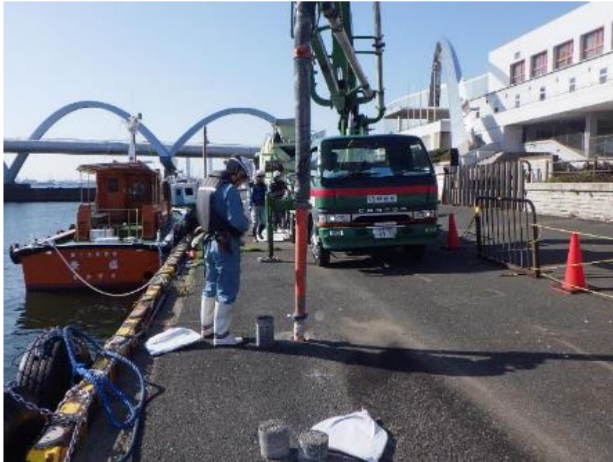
コンクリートポンプ車
