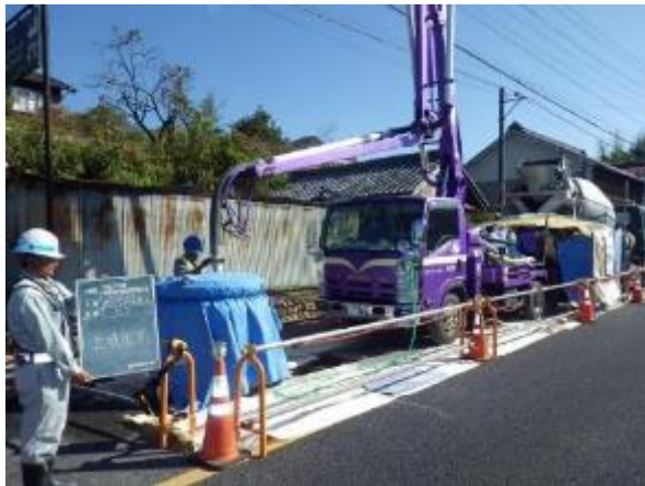
打設状況 (コンクリートポンプ車)
