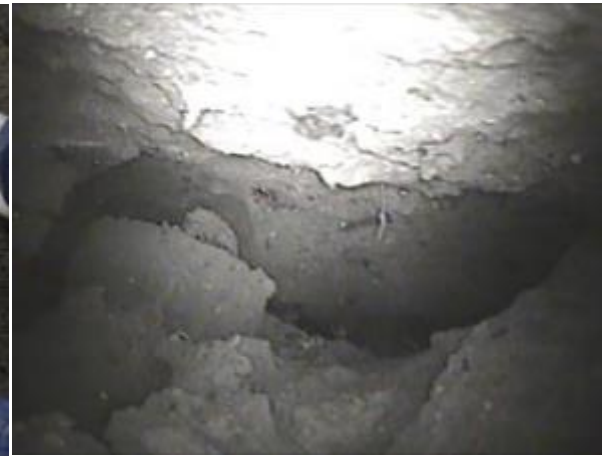
空洞カメラ調査の映像
