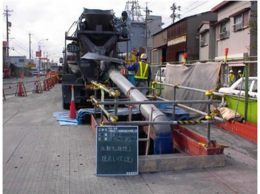
アジテーター車（運搬車）から直接
