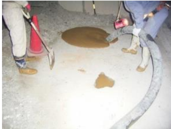
充填状況（地下ピット）
