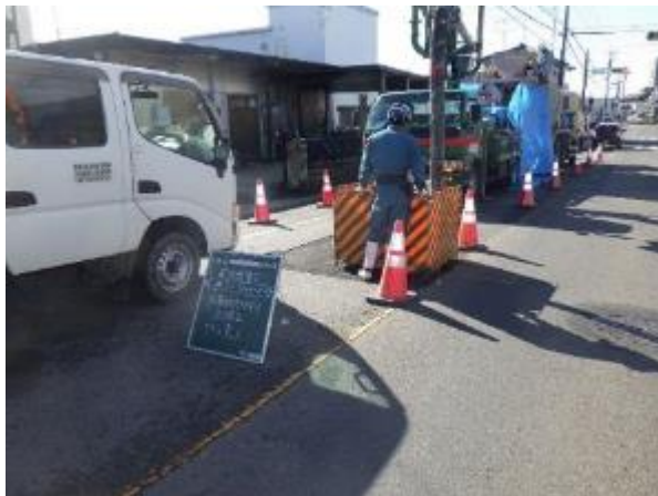
充填状況 (コンクリートポンプ車)
