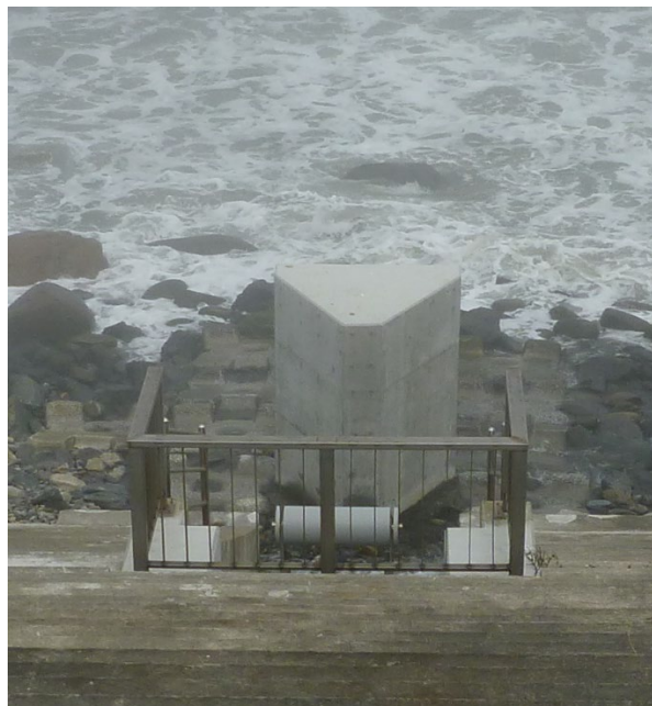
設置現場の状況
