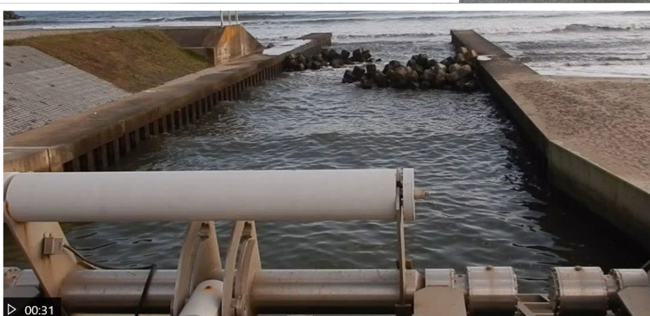
設置現場の状況
