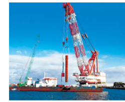
テーパー杭打設の様子
