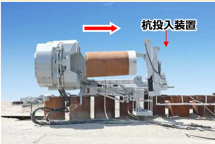
③鋼管杭投入
