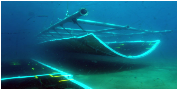
洗掘防止用アスファルトマット
