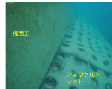
アスファルトマット敷設後の状況 (腹付工部)
