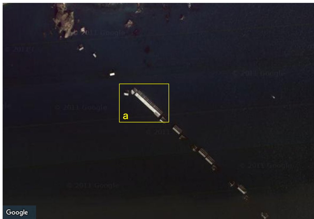
釜石港湾口防波堤・北堤全景
