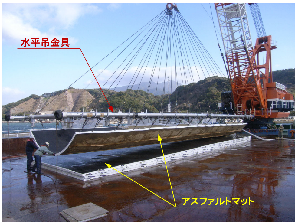
専用の「水平吊金具」を使用し、埋設したワイヤーロープでアスファルトマットを吊上げた状況
