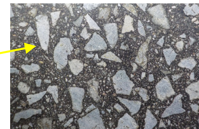
マット切断面 (無空隙合材)
