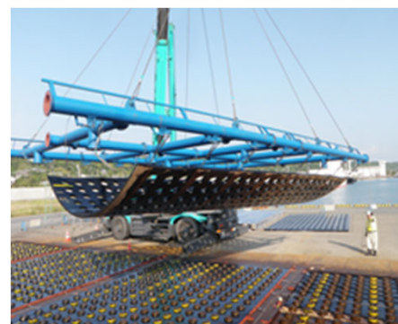
アスファルトマット吊上げ状況 (全面孔あきタイプ)
