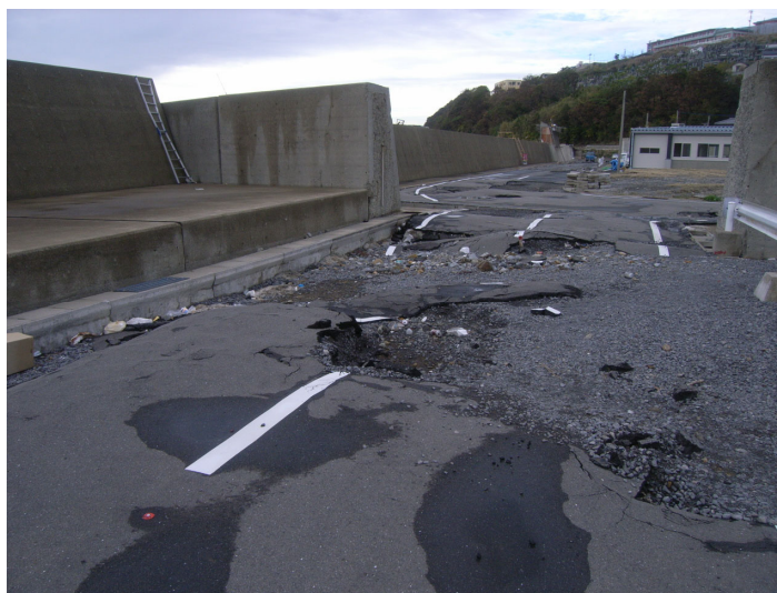
護岸背面の土砂吸出しによる被災状況
