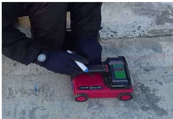
1. 墨だし・鉄筋探査
