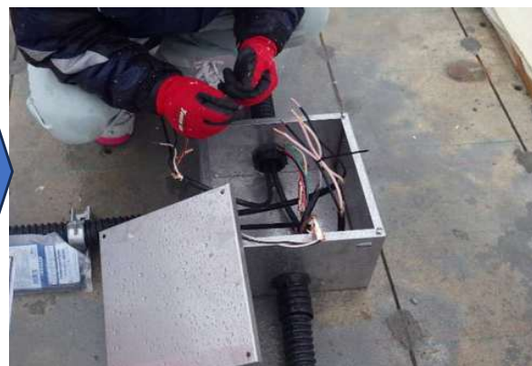
5. 結線・配管配線工
