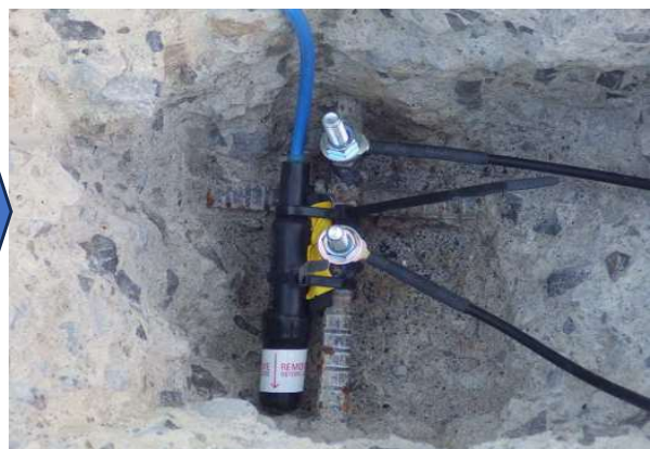
4. 陰極・照合電極設置
