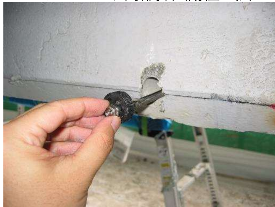
チタンロッド内部挿入陽極工法
