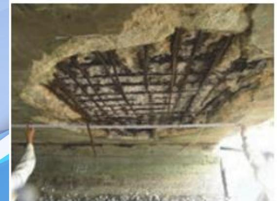
内部の鉄筋が露出した橋梁
