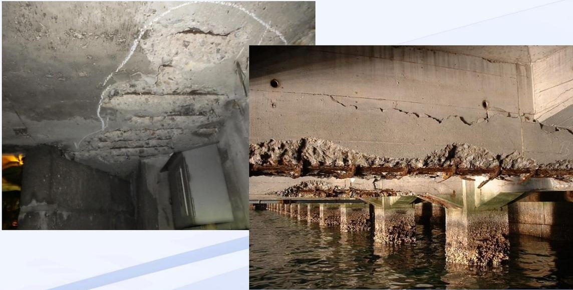
コンクリート内部の鉄筋が腐食
