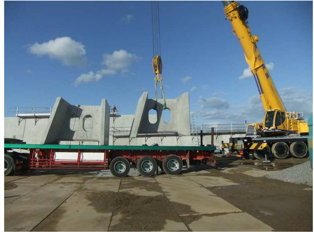
トレーラーで搬送し、現地で荷卸し
