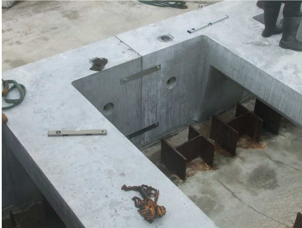
プレキャスト製品内側に埋め込まれているインサートに金具で連結
