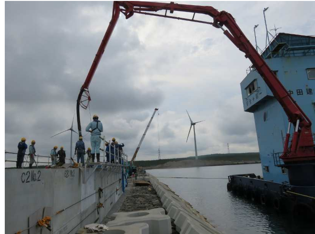
製品据付後、中詰めコンクリートを 打設
