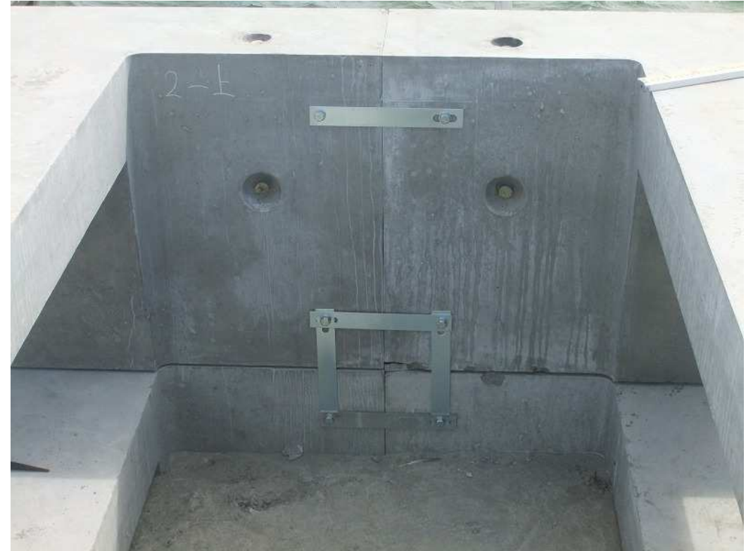
1段目と2段目の上下連結状況
