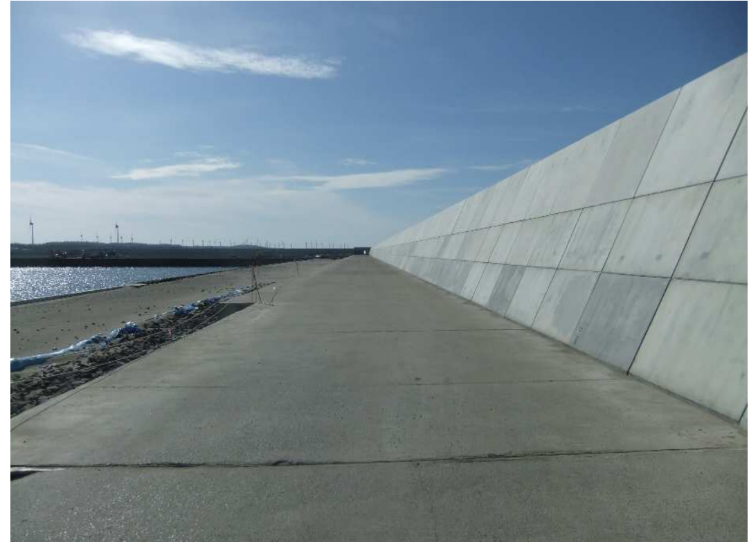
パラペット施工完了
