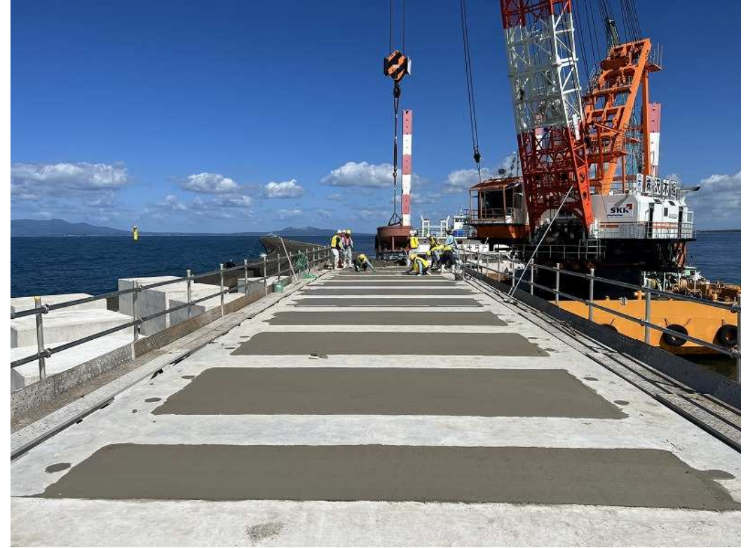
プレキャスト製品の部材上でコテ均 し作業が可能
