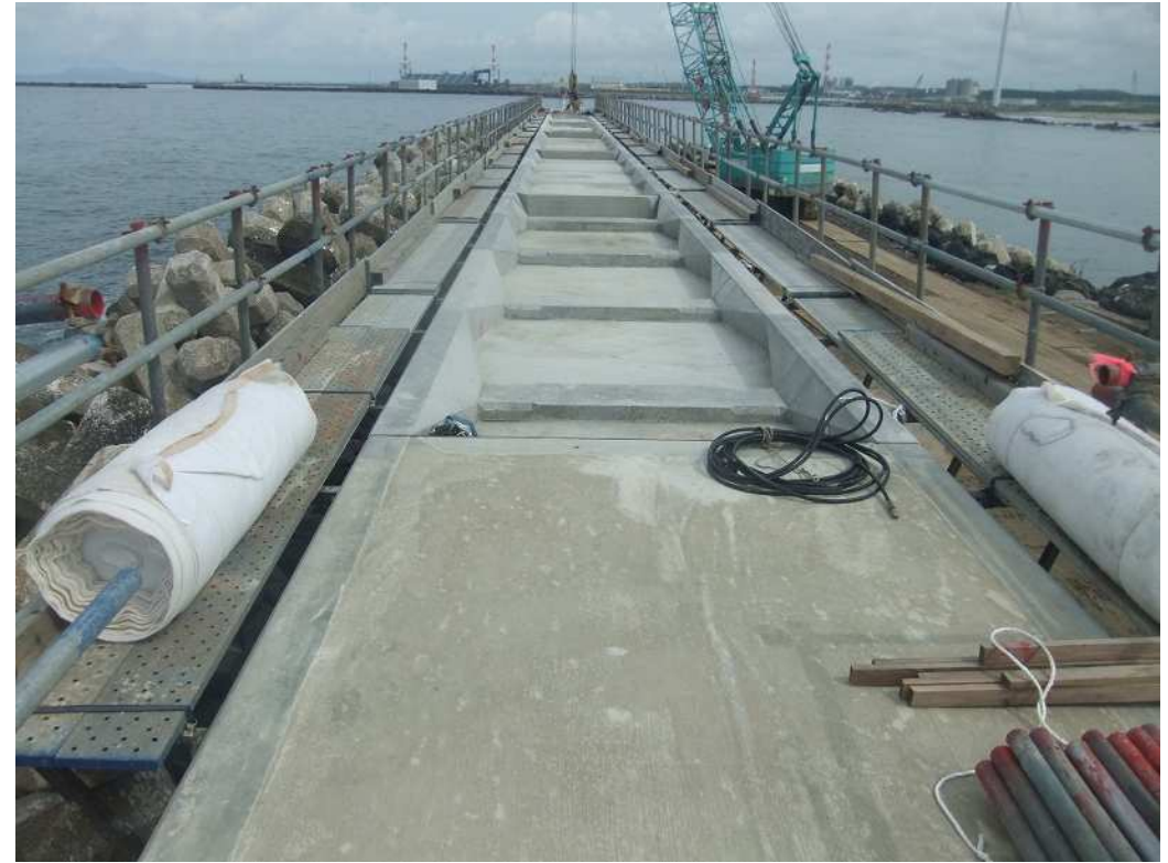
天端仕上げ状況
