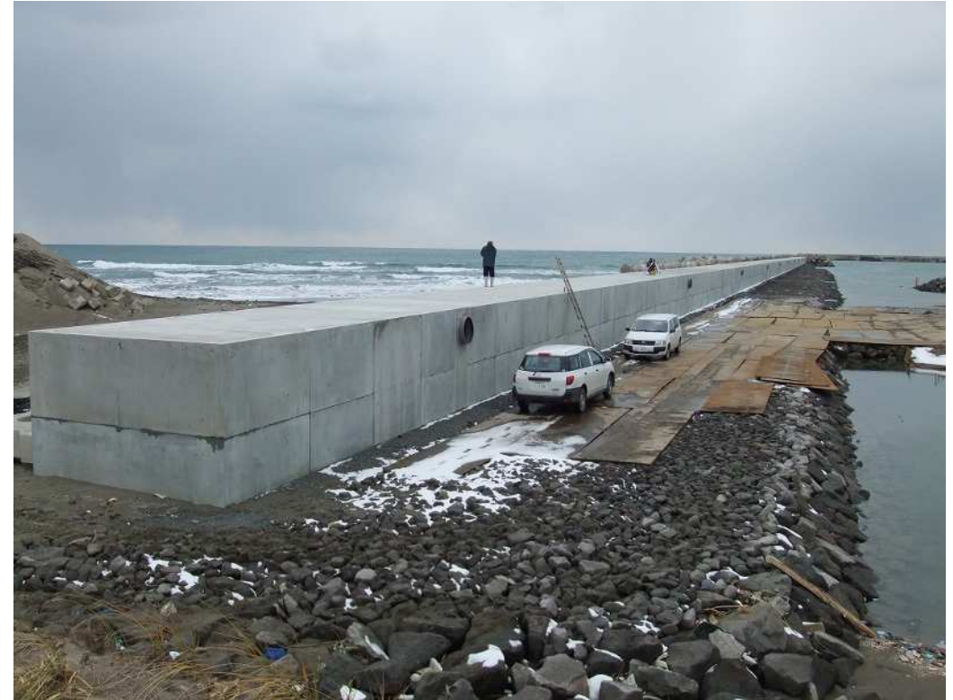
上部工本体施工完了
