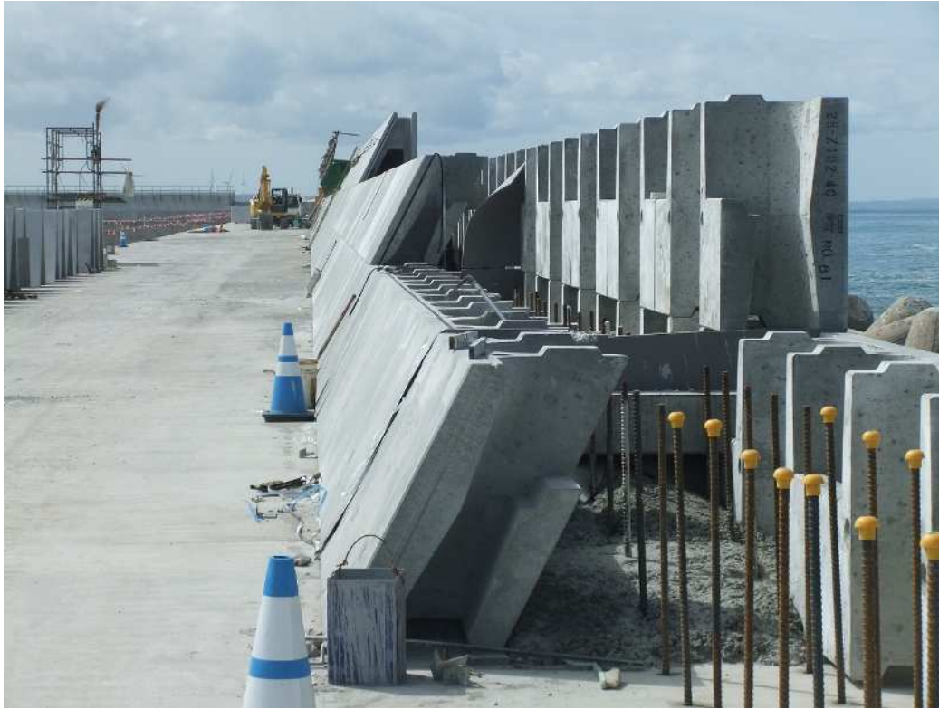
パラペットの施工状況
