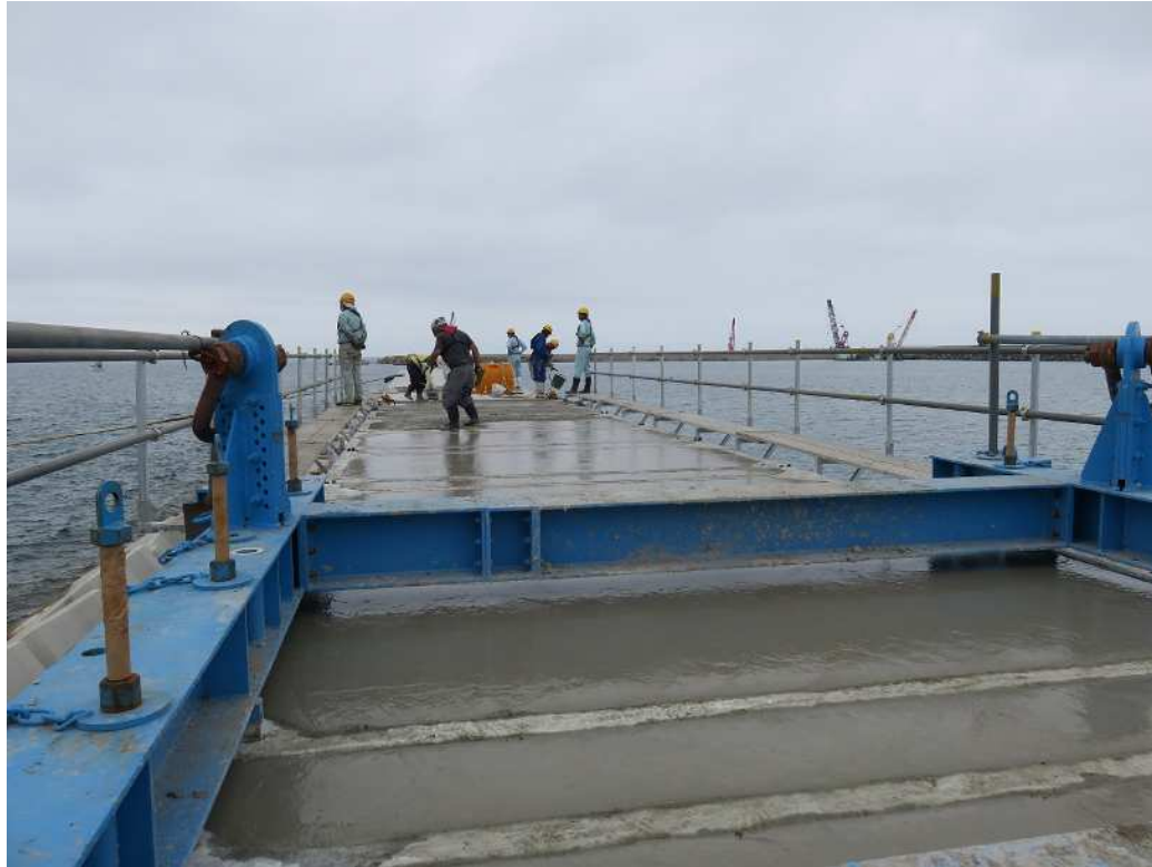
コテ均し状況
