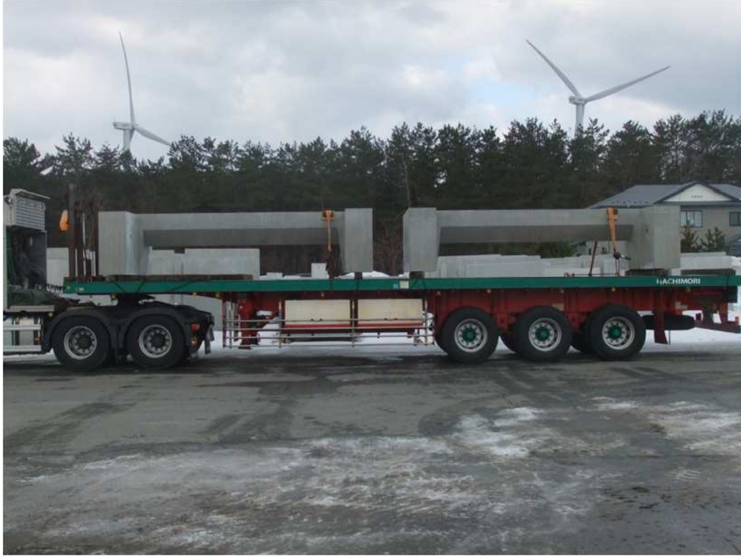
工場でプレキャスト製品を製作し、 トレーラーで搬送
