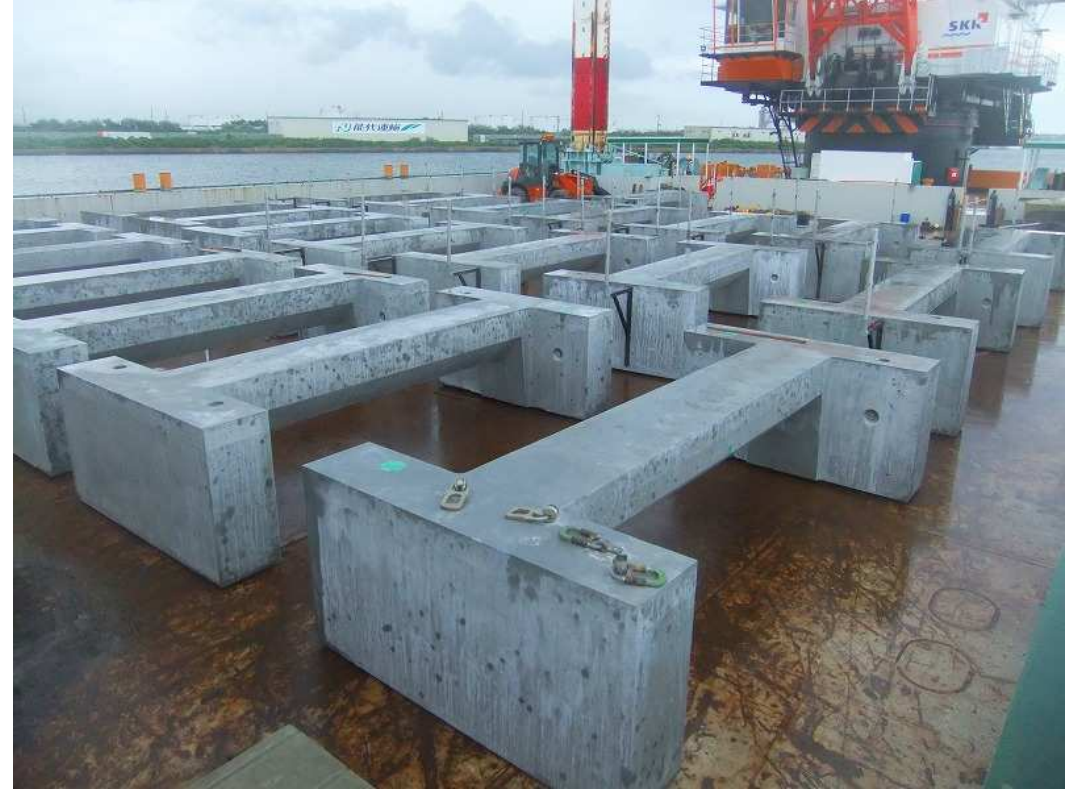
プレキャスト製品を台船に積載し、 施工現場へ搬送
