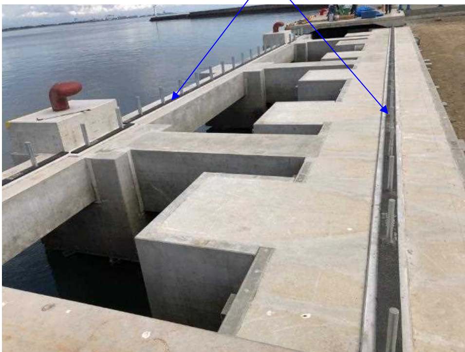
PC床版架設前状況
