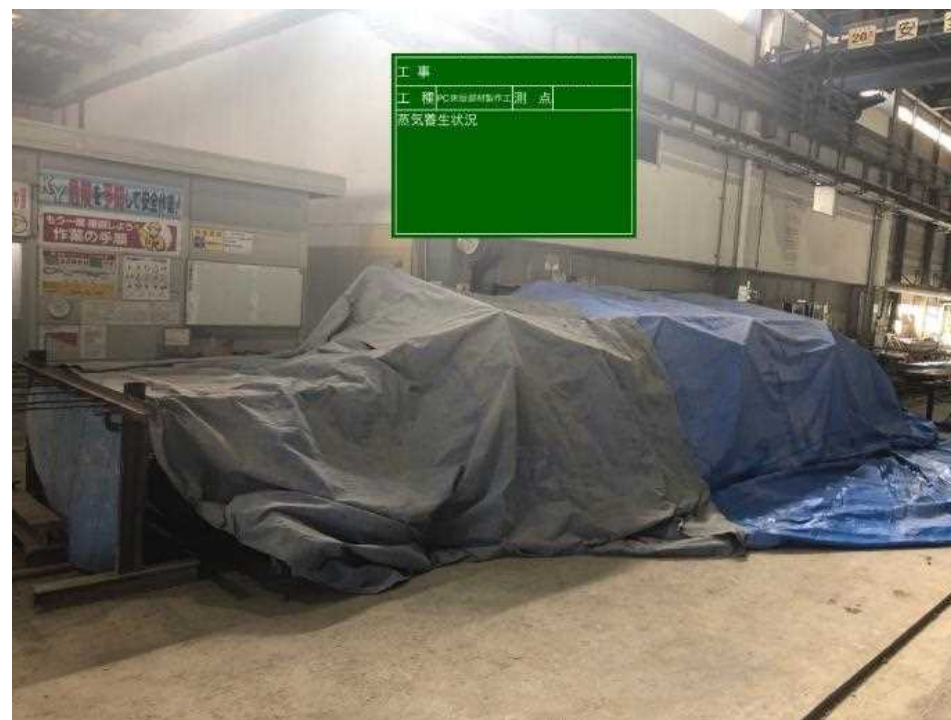
養生状況（蒸気促進養生）
