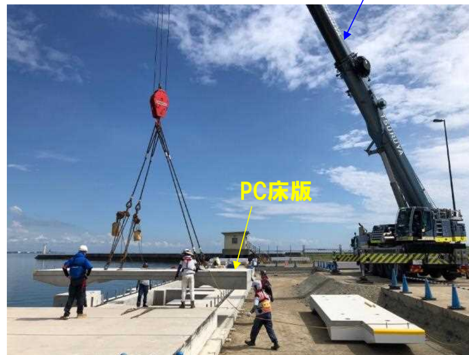
PC床版架設状況
