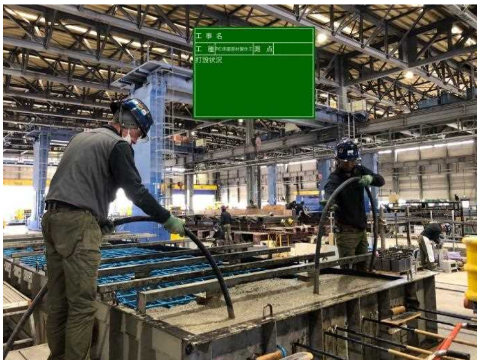
コンクリート打設状況
