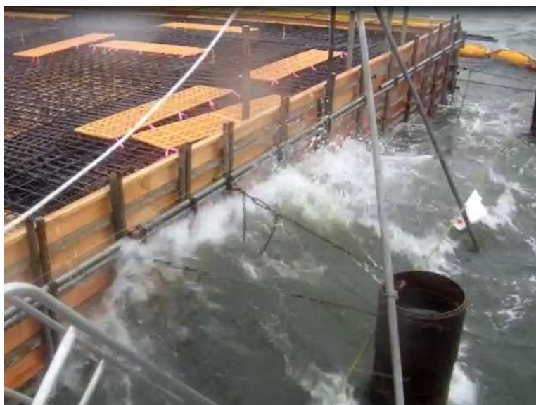
従来工法(現場打ちRC) 施工状況例
