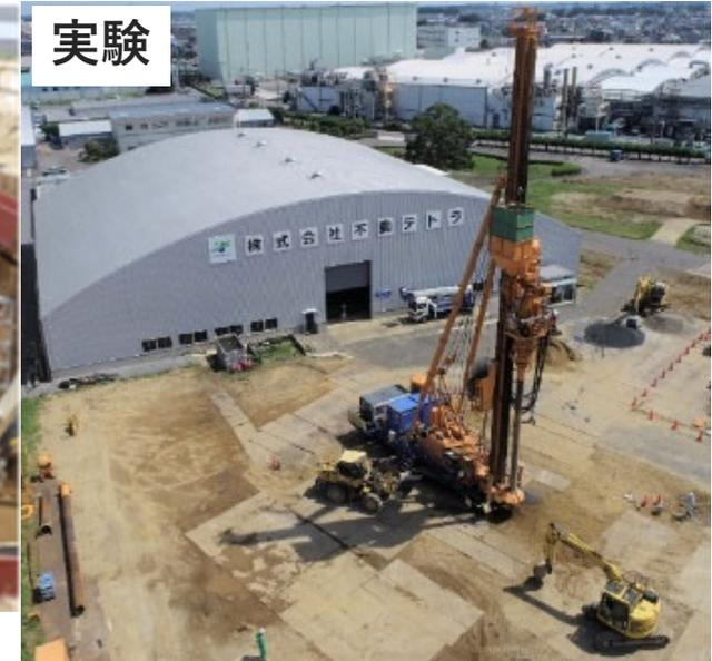
行方砂を30cm層厚で埋戻して土層作成
