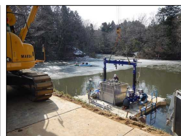
【浚渫設備組立状況】
