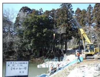
【作業台船進水状況】
