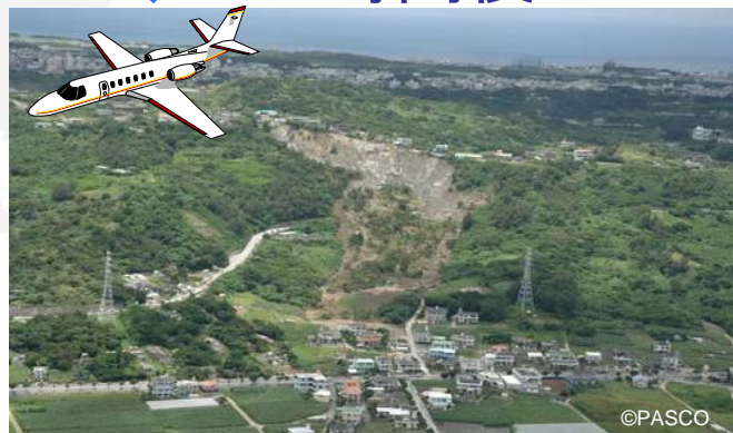
被害状況写真
