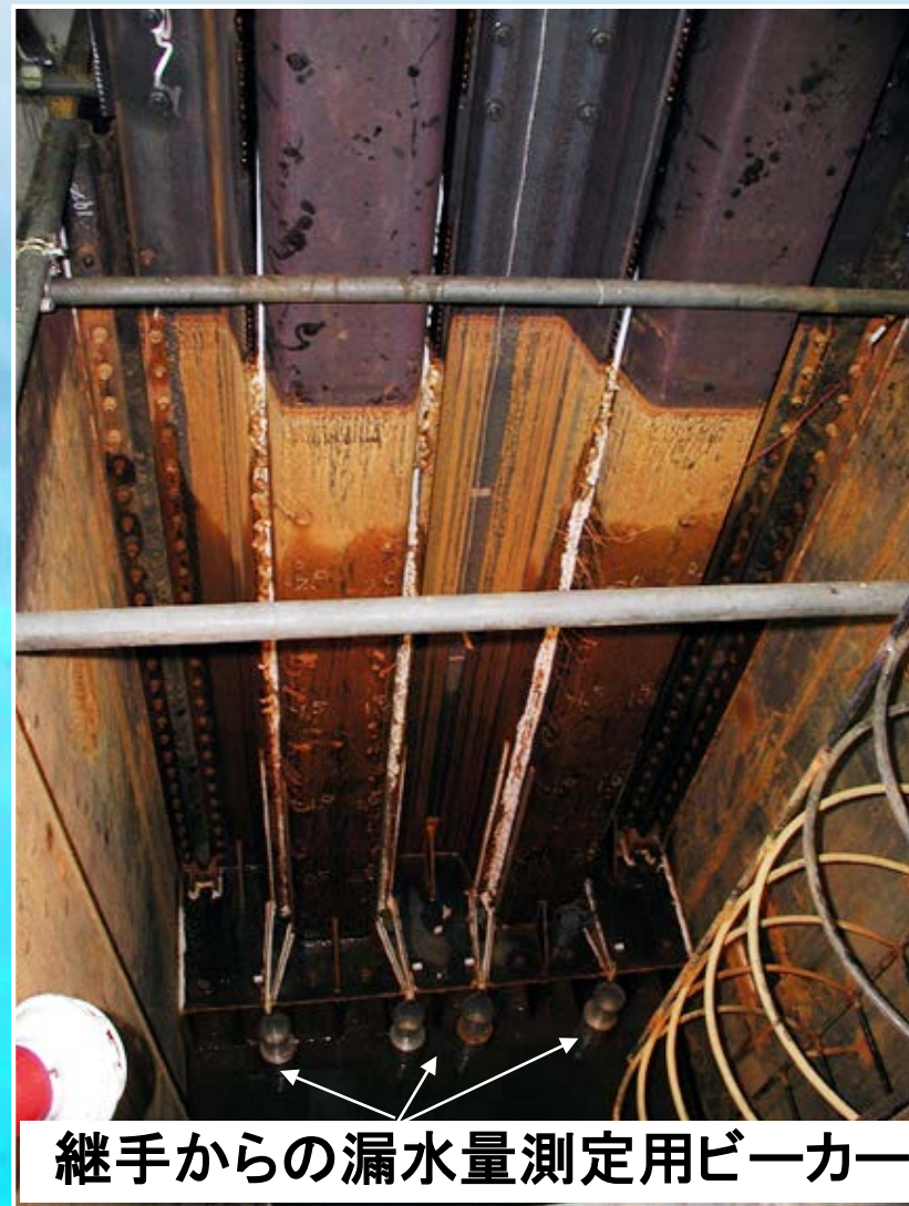
水槽内状況(ドライ側)
