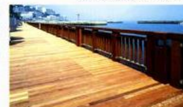
熱海親水公園護岸柵：静岡県
