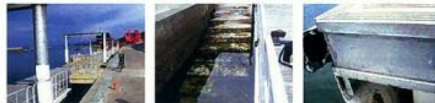
(1974年設置) 大阪府青少年海洋センター浮桟橋(大阪府堺市):アルミニウム合金製(生地材、耐腐蝕部は塗装)
