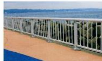
鴨川漁港護岸柵：千葉県
