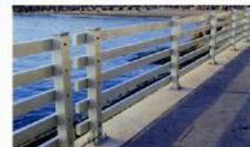
明石西外港護岸柵：兵庫県
