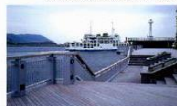
鹿児島本港護岸柵：鹿児島県
