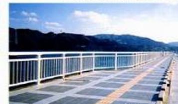
和歌山マリナシティ護岸柵：和歌山県
