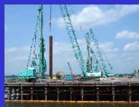
鋼管矢板打設
