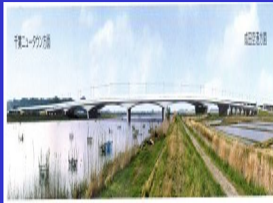
印旛沼橋梁完成イメージ写真
