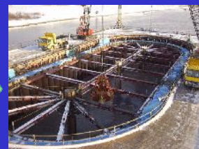
掘削・ドライアップ
