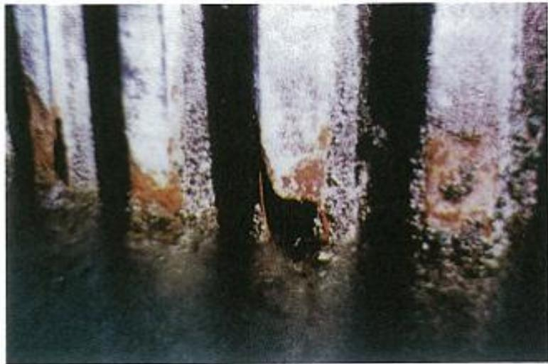
写真-1.2.4 集中腐食によって発生した穴 <sup>14), 15)</sup>
