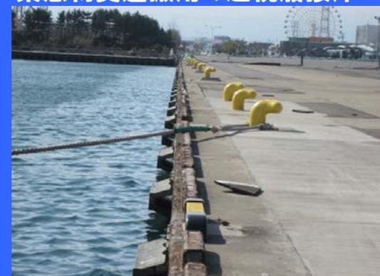
補強部の岸壁法線はらみ出しなし H23.3.19
