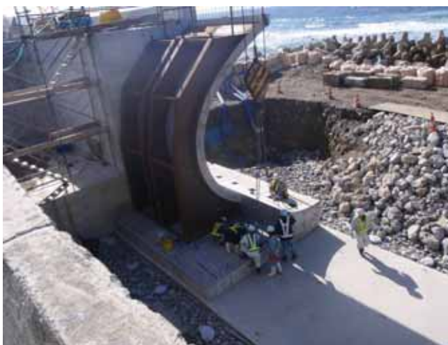
底版ブロック据付状況
