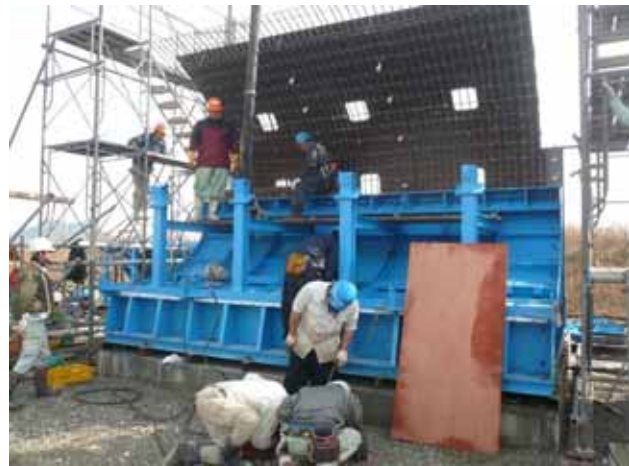
前壁部鋼製型枠設置
