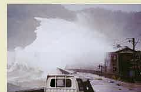
従来の護岸形式での被害状況
