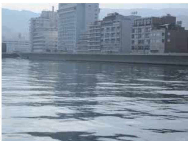
63函据付完了 2011.12.12現在
