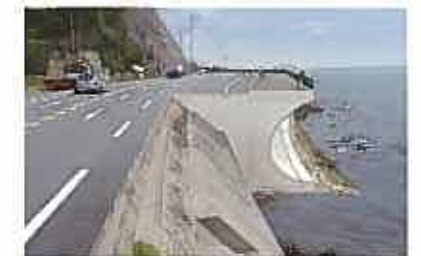
フレア護岸により道路拡幅
