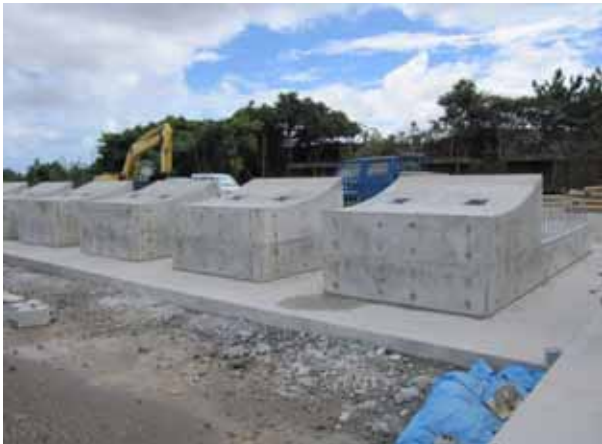
底版部製作状況
