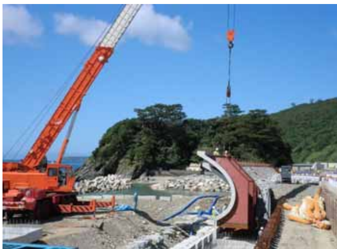
前壁ブロック据付状況2
