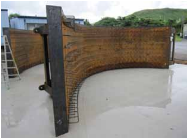
鋼殻ブロックヤード搬入
