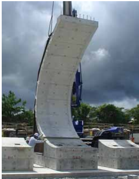
上部・底版部接合状況
