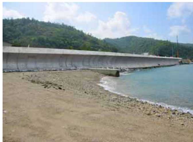
フレア護岸据付 81函(162m)
