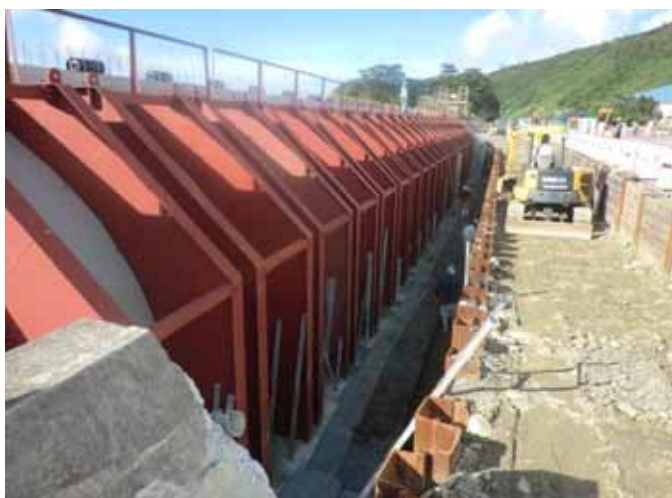
据付状況（フレア護岸背後状況）
