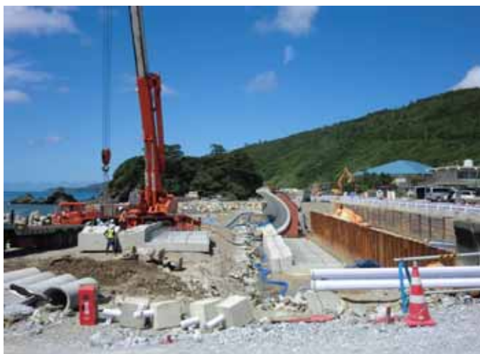
底版ブロック仮置状況
