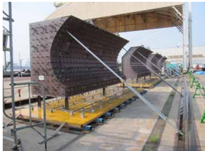
ブロック製作時鋼殻据付
