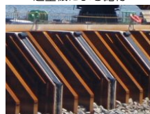
防砂目地板設置
