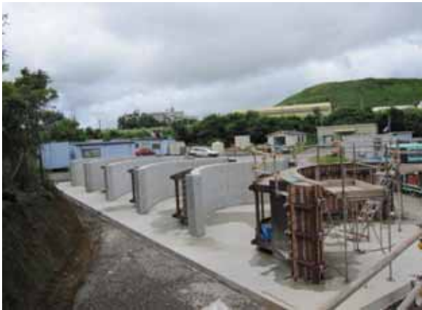
ブロック製作状況
