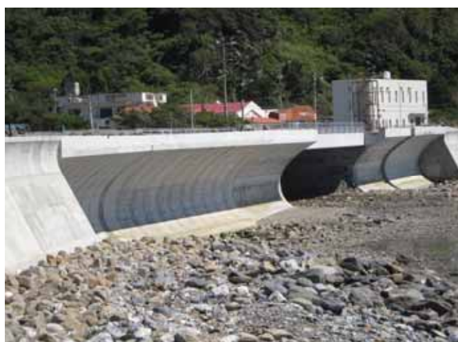
フレア据付後 2011.6.15現在状況
