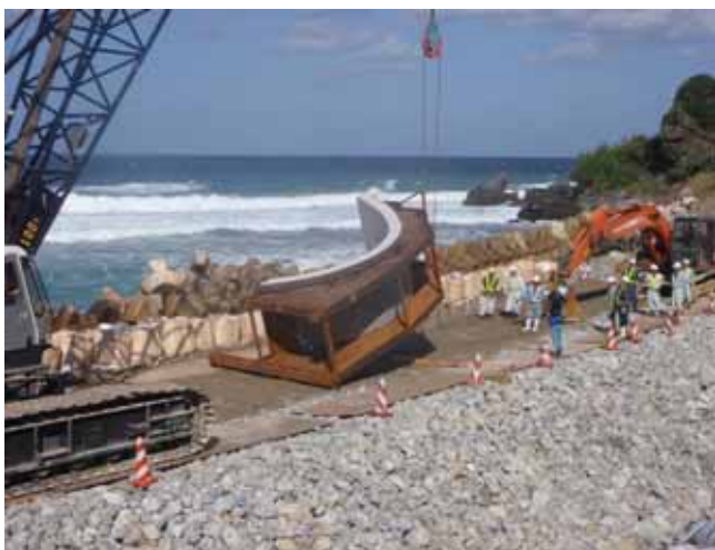
前壁ブロック立起こし状況
