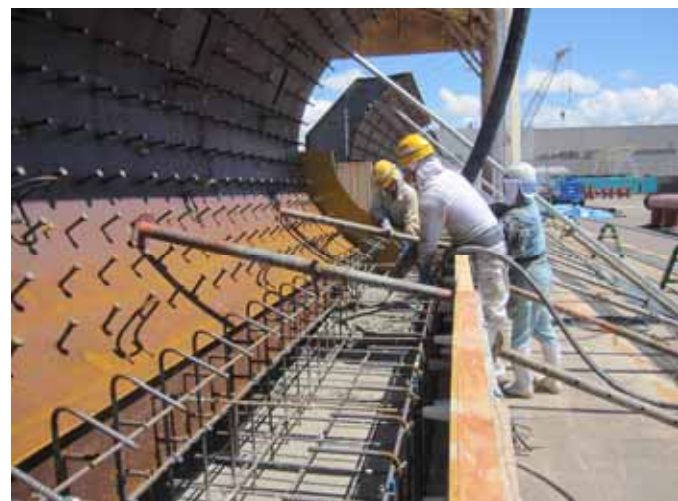
底板部コンクリート打設
