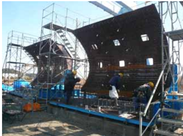
底版部鉄筋組立
