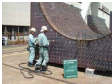
スタッド溶接
