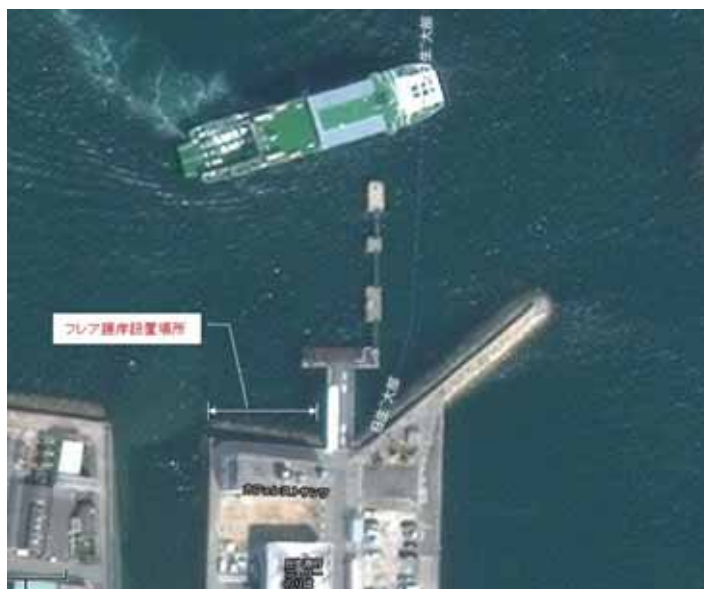
フレア護岸設置場所
