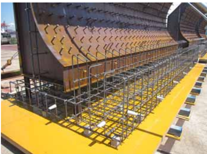
底板部鉄筋組立
