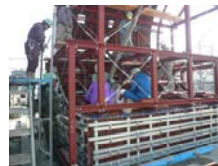
コンクリート打設
