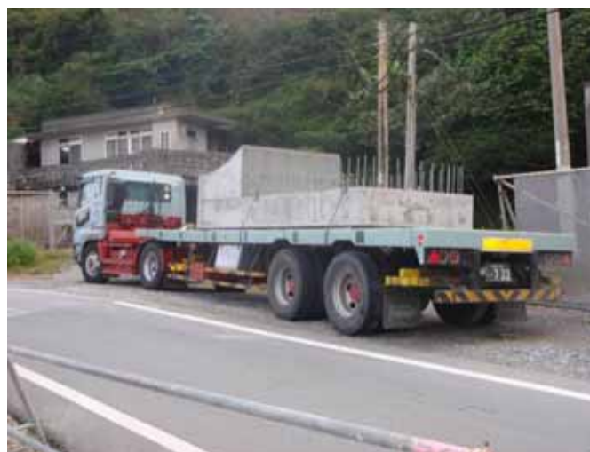
底版ブロック搬入状況
