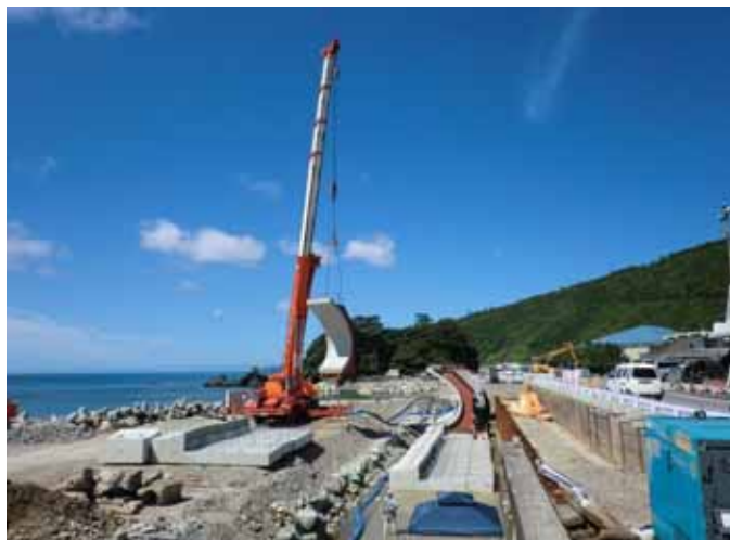
前壁ブロック据付状況1
