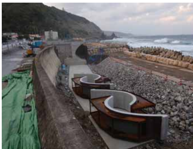
宇嘉据付ヤード全景
