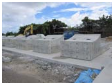
底版ブロック
