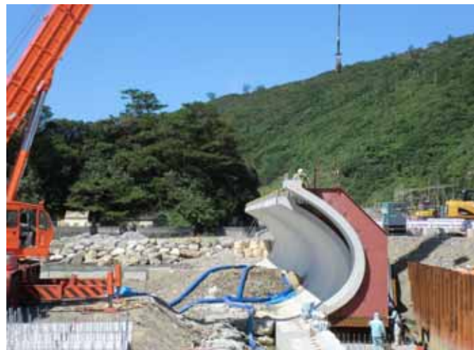
前壁ブロック据付状況3
