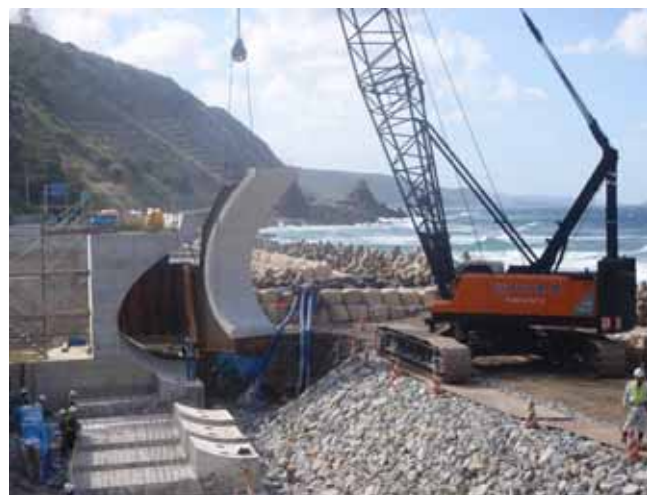
前壁ブロック据付状況
