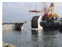
起重機による据付
