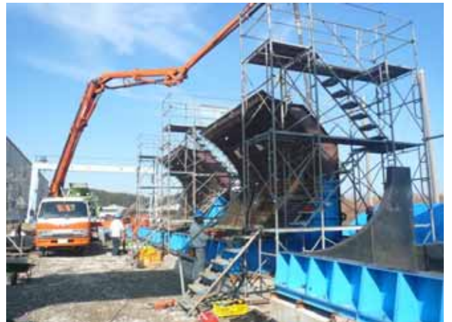
底版背後部コンクリート打設
