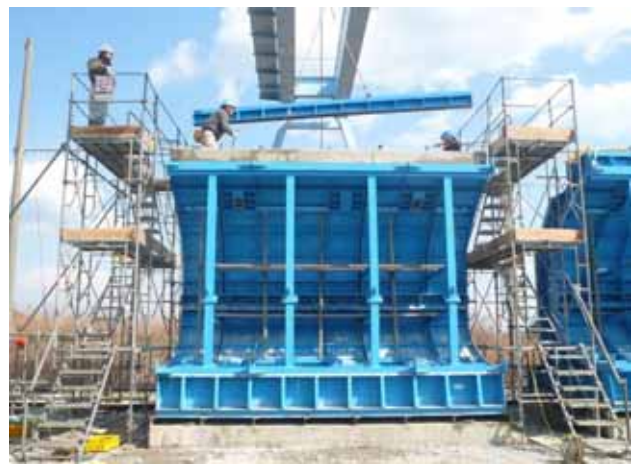
鋼製型枠脱型
