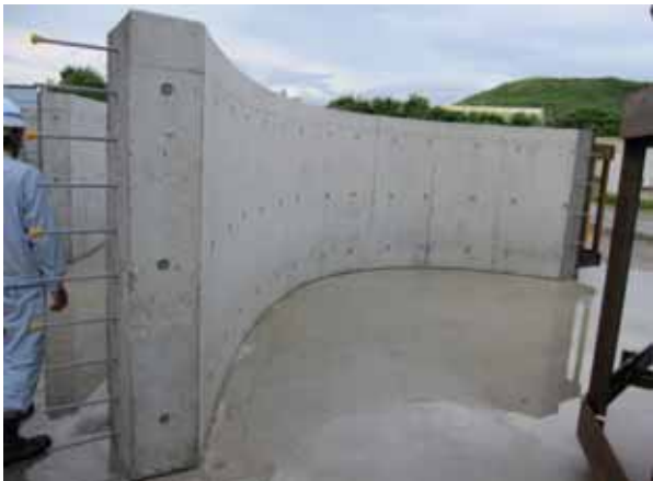
上部（円弧部）製作状況
