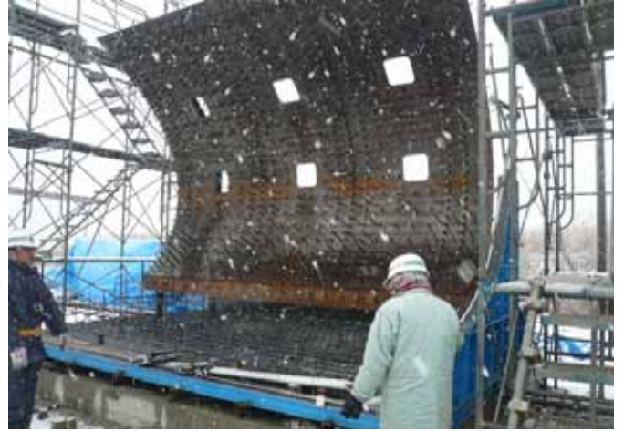
ブロック製作時鋼殻据付
