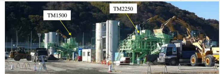
ツイスターによる事前混合処理プラント(清水港新興津泊地(-15m)土捨工事にて施工中)
