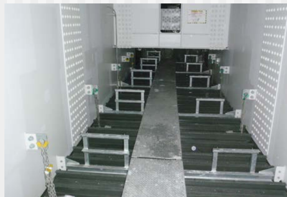
FRP飛来塩分防護板 沖縄科学技術大学院大学2号橋
