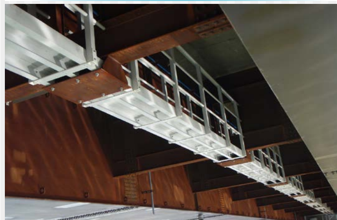
瀬戸中央橋上部工検査路(長崎県)
