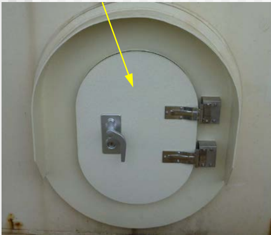
ヒンジ式マンホール蓋 (取替工事:白鳥大橋)
