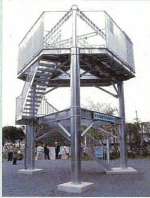
津波避難タワー
